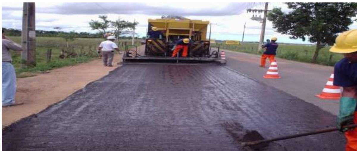
En la figura N° 4, se observa el proceso de aplicación sistemática del MPAF en una vía de transporte, siendo un carril el área en mantenimiento para afirmar la vía en recuperación de los daños ocasionados por el transporte pesado.
