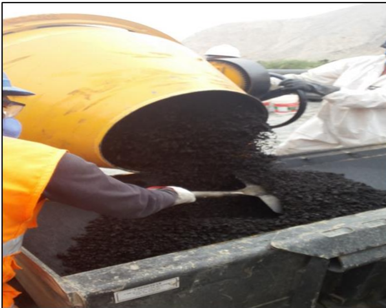
Figura 18: Fabricación con mezcladora tipo trompo.
