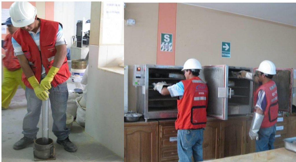
Personal Técnico ejecutando los ensayos de la prueba Próctor
