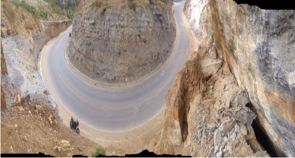
Inestabilidad de taludes
