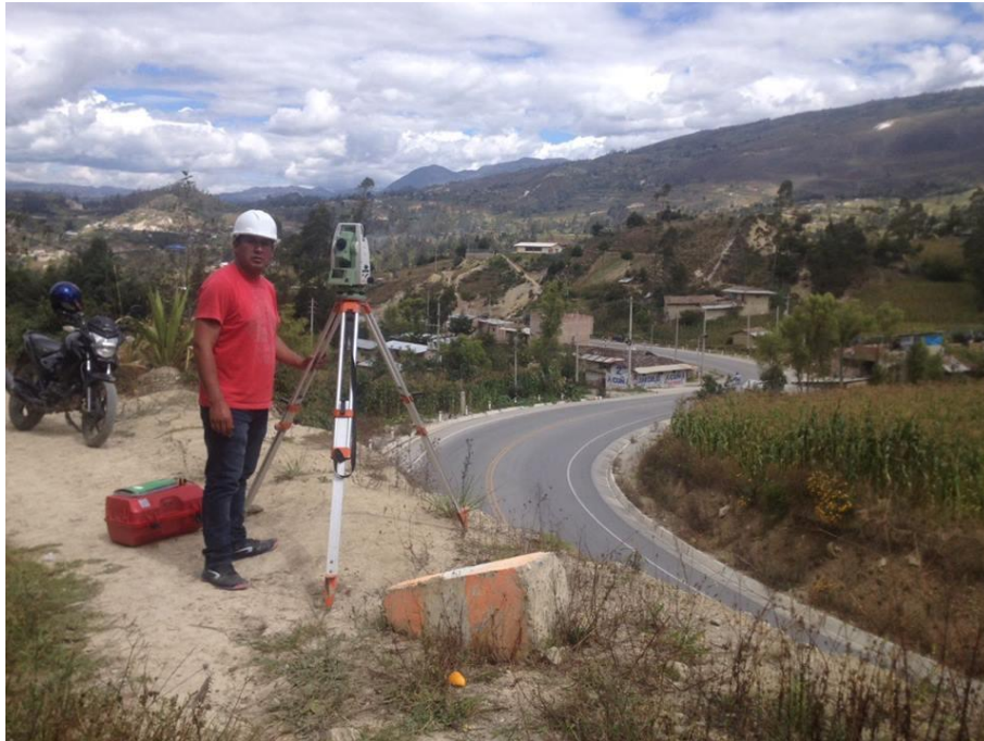
Utilizando el nivel de ingeniero para verificar las pendientes
