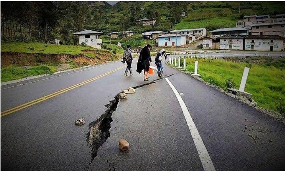
Fisuras pronunciadas en la carretera
