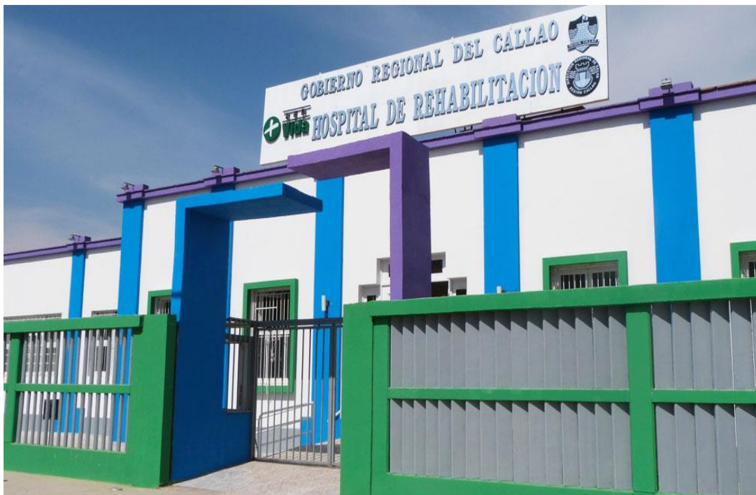
Figura 8. Fachada del Hospital de Rehabilitación del Callao. Fuente: Captura de internet
