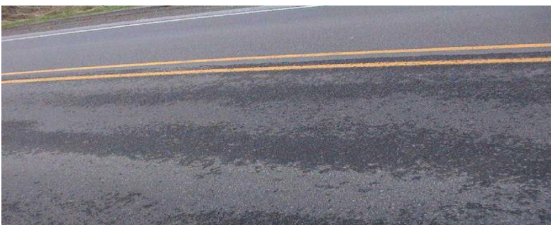
Figura 9. Exudación. La exudación se evidencia a través de una película de asfalto que se extienden sobre la superficie de la pista
