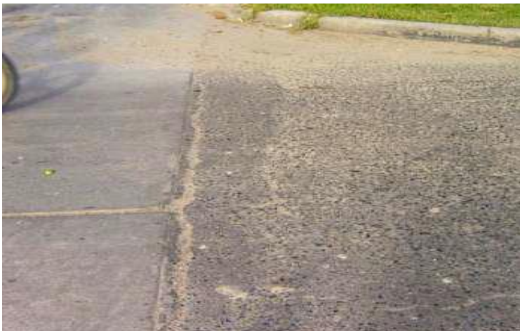
Figura 20. Desplazamiento.
