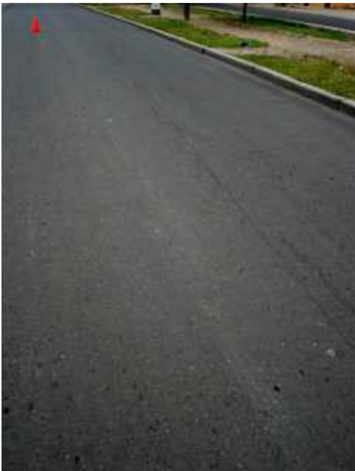
Figura 19. Ahuellamiento
