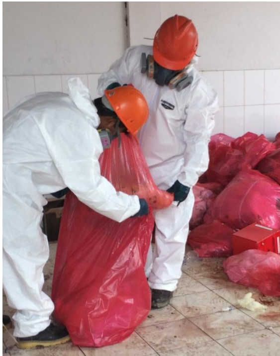
Se evidencia a los trabajadores de la EPS-RS con la indumentaria adecuada.
