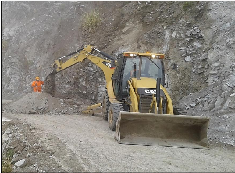
Foto N° 02: Retroexcavadora CAT 420F atendiendo los servicios Fuente: El autor
