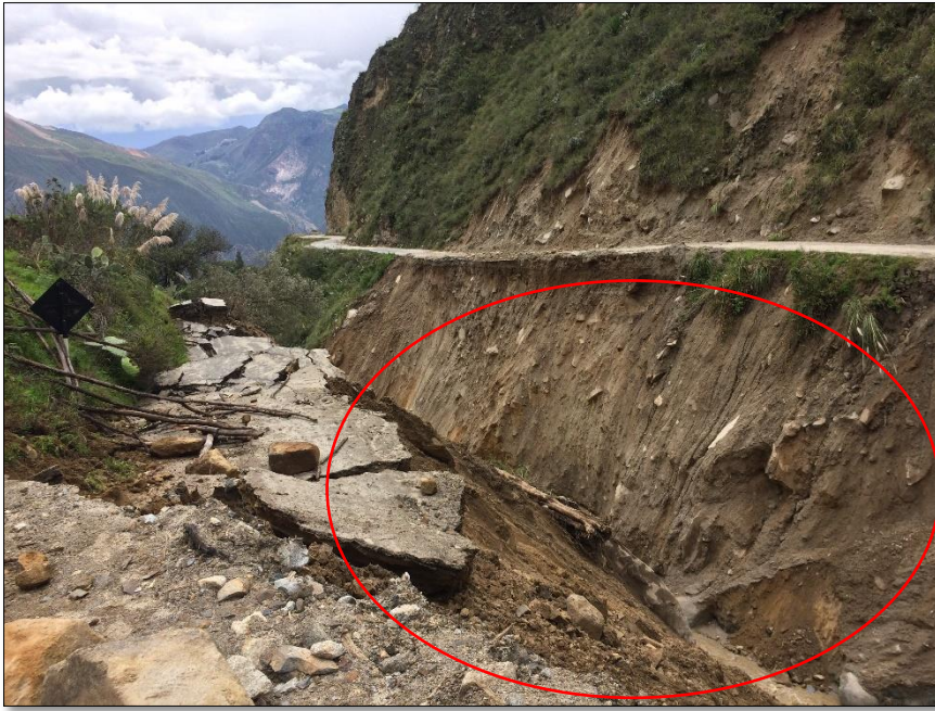
Foto N° 04: Servicios viales Fuente: El autor
