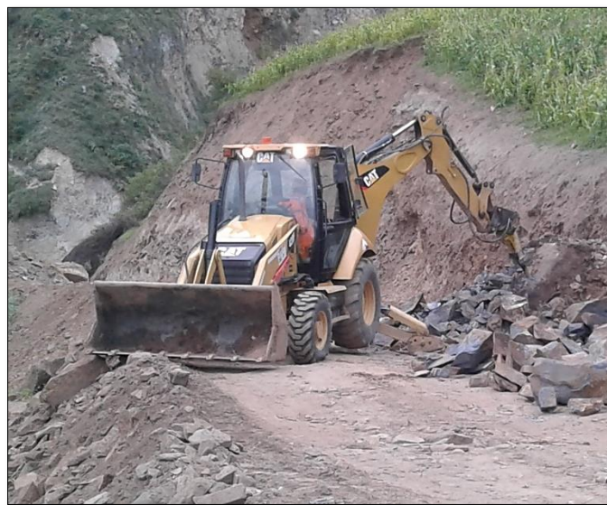
Foto N° 01: Retroexcavadora CAT 420F
