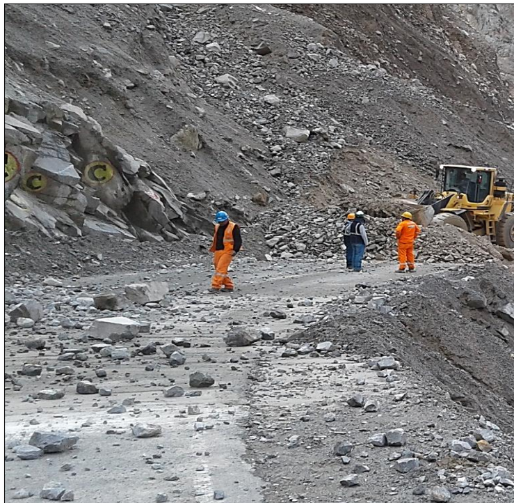
Foto N° 03: Retroexcavadora CAT 420F atendiendo los servicios por emergencias viales Fuente: El autor
