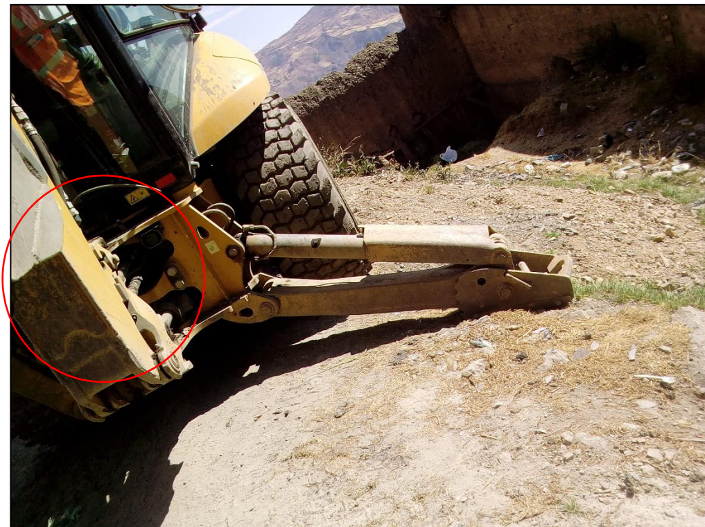
Foto N° 07: Falla en sistema de traslación Fuente: El autor
