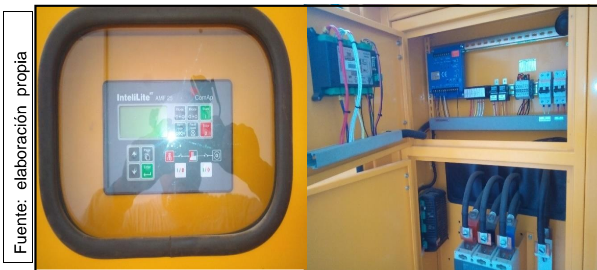
Pantalla de visualización parte frontal y posterior del controlador AMF 25
