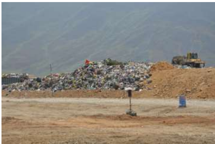
Fuente: Innova Ambiental Figura 30. Relleno Sanitario Portillo Grande
