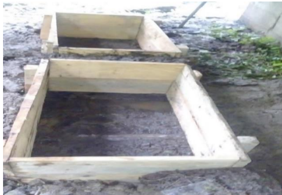
Figura 4: zanjas de los humedales artificiales
