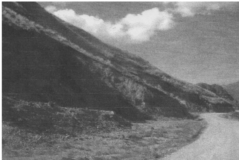
Grafico 9: Vista del talud de la cantera km 15+ 100.
