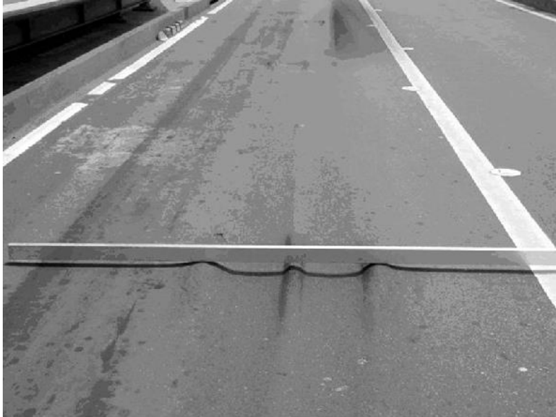
Figura 22: Ahuellamiento
