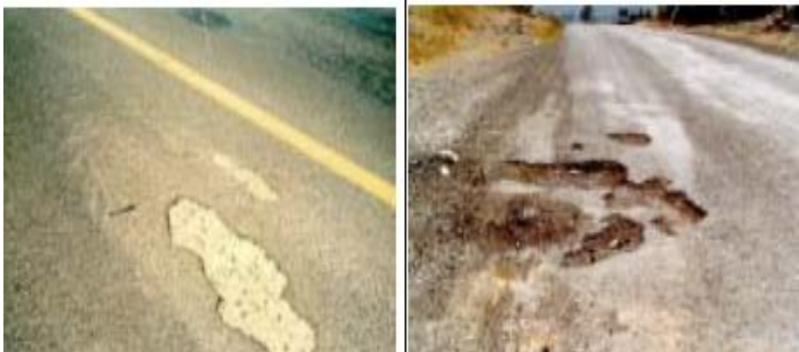
Figura 26: Desplazamiento de agregados
