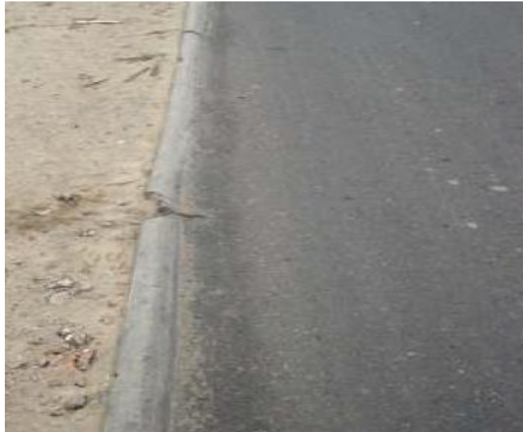
Figura 23: Desplazamiento
