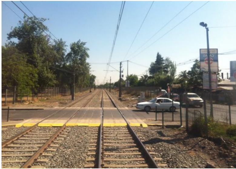
Figura 21: Cruce de vía férrea
