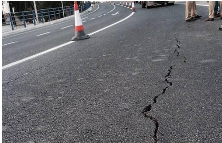
Figura 16: Grietas longitudinales
