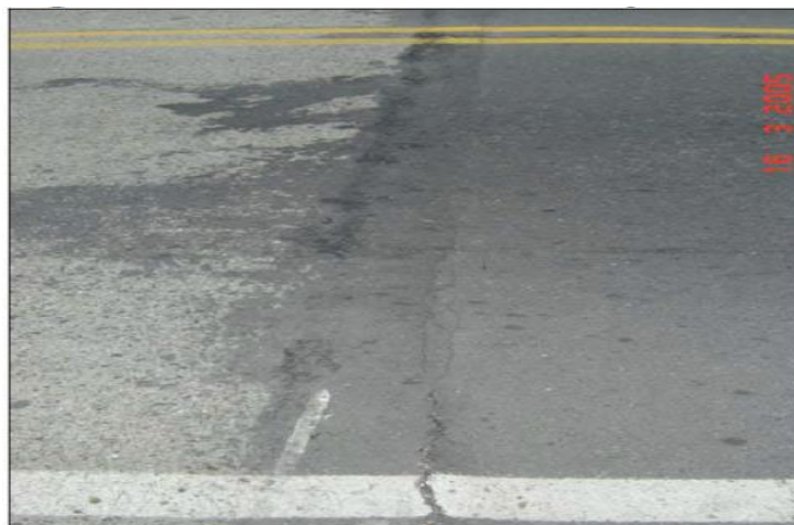
Figura 17: Grietas transversales
