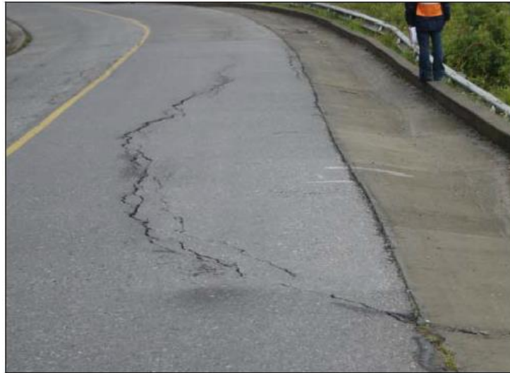
Figura 24: Grieta parabólica
