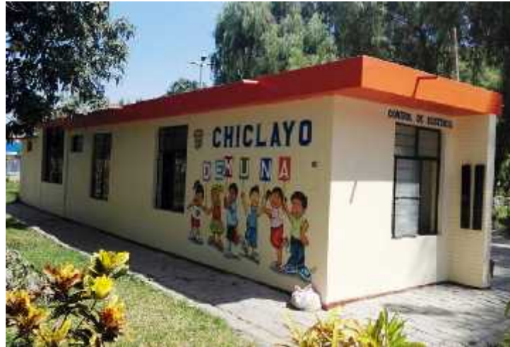
Figura 2. Exteriores de la infraestructura de la DEMUNA - Chiclayo
