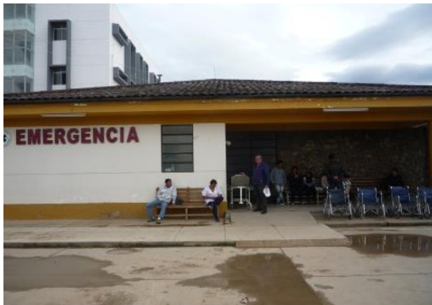
PUERTA DE INGRESO GENERAL A EMERGENCIA DEL HOSPITAL REGIONAL VIRGEN DE FATIMA
