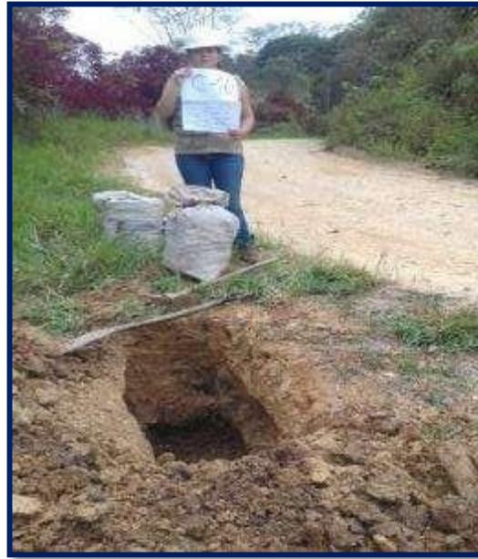
Imagen 1: Se puede observar la excavación de la calicata N°10 y sacado de muestras.
