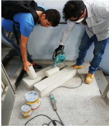
Figura N° 21 Retiro de residuos y polvos Fuente: elaboración propia.
