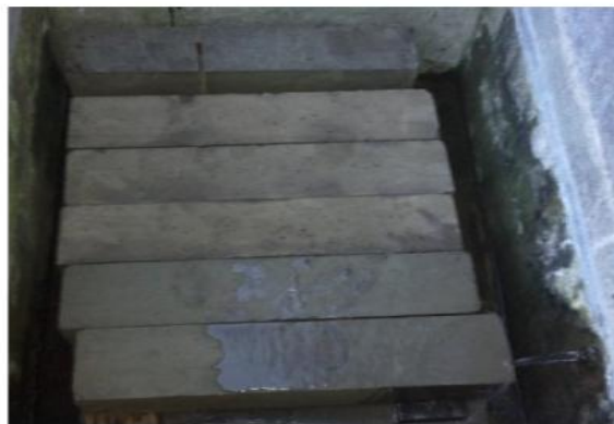
Figura N° 39 Curado de las vigas Fuente: Elaboración propia.
