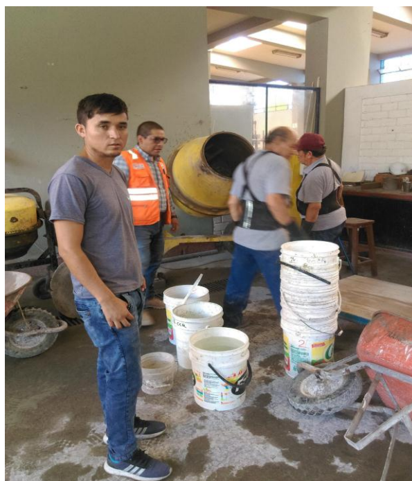
Figura N° 19 Elaboración de las probetas Fuente: elaboración propia.
