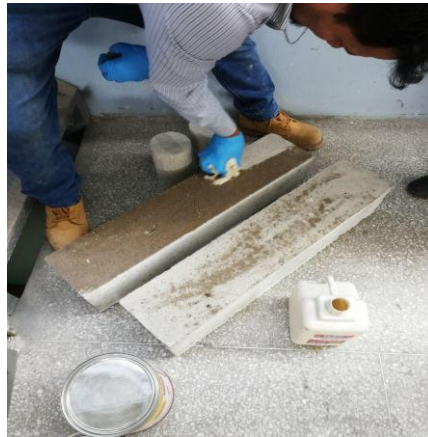
Figura N° 42 Limpieza de las vigas probetas con solvente Fuente: Elaboración propia.
