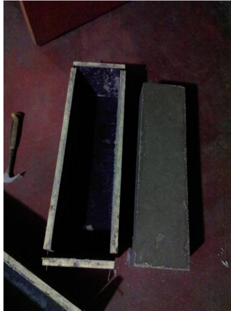
Figura N° 38 Desencofrado de vigas Fuente: Elaboración propia.
