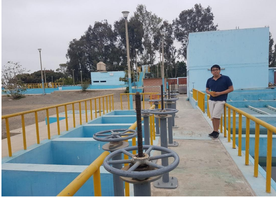
FOTO N° 03 Vista del Estado Actual de Planta de Tratamiento de Agua Potable
