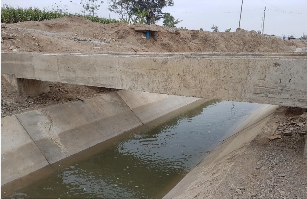
FOTO N° 01 Vista del Estado Actual de Línea de Conducción
