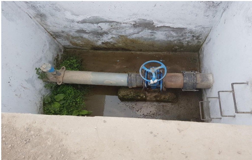
FOTO N° 02 Vista del Estado Actual de Línea de Conducción
