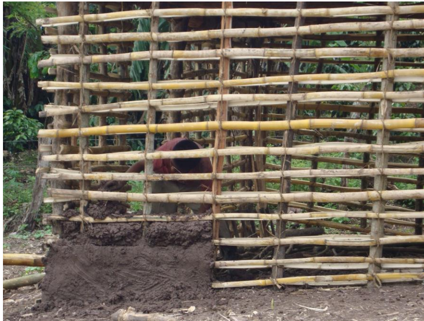
Figura 7: Pared hecha con Bambú en su interior y revestida con Barro
