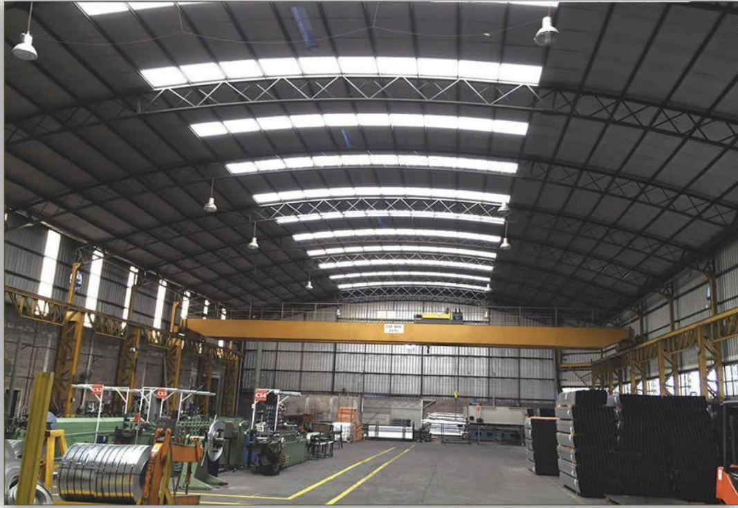
Figura 1.2. Nave industrial metálica con puente grúa birriel (Metalúrgica Cecchi, 2017)
