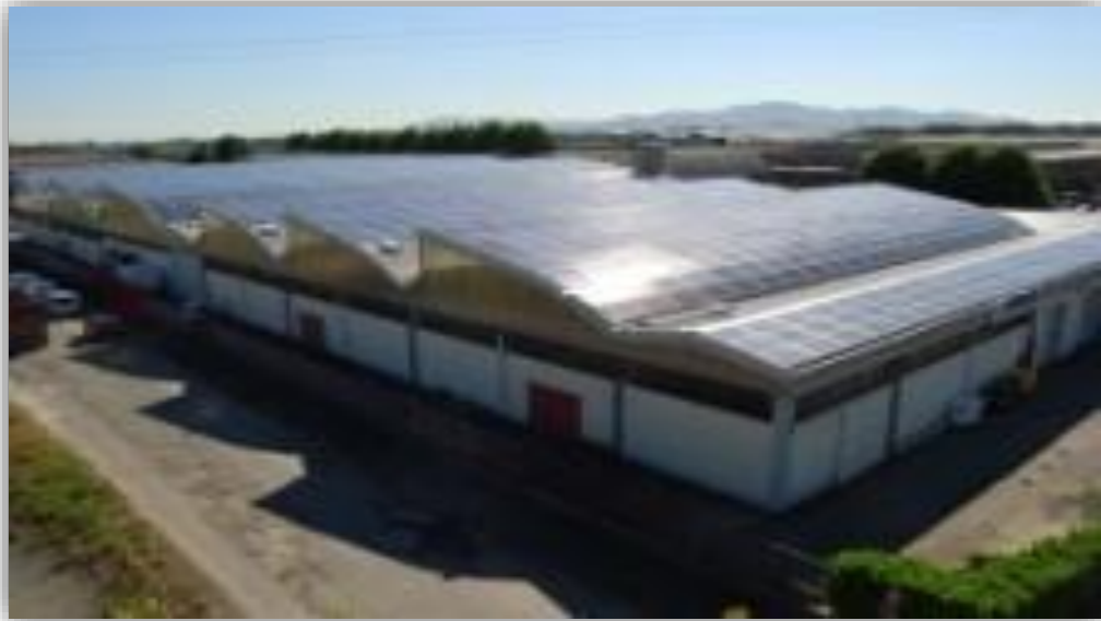
Figura 1.19. Techo tipo sierra con cubierta de paneles solares.
