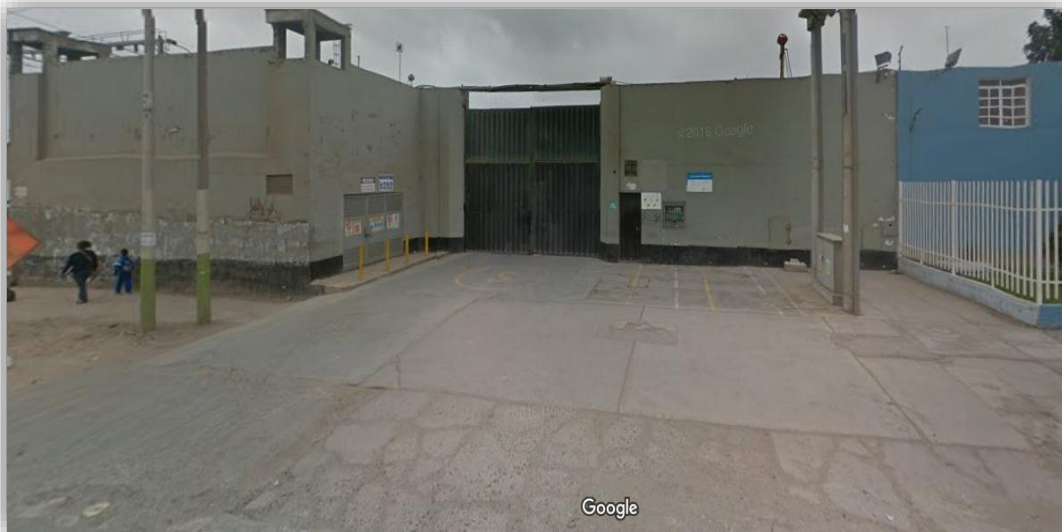
Figura 3.2. Vista frontal del predio (Google Maps)
