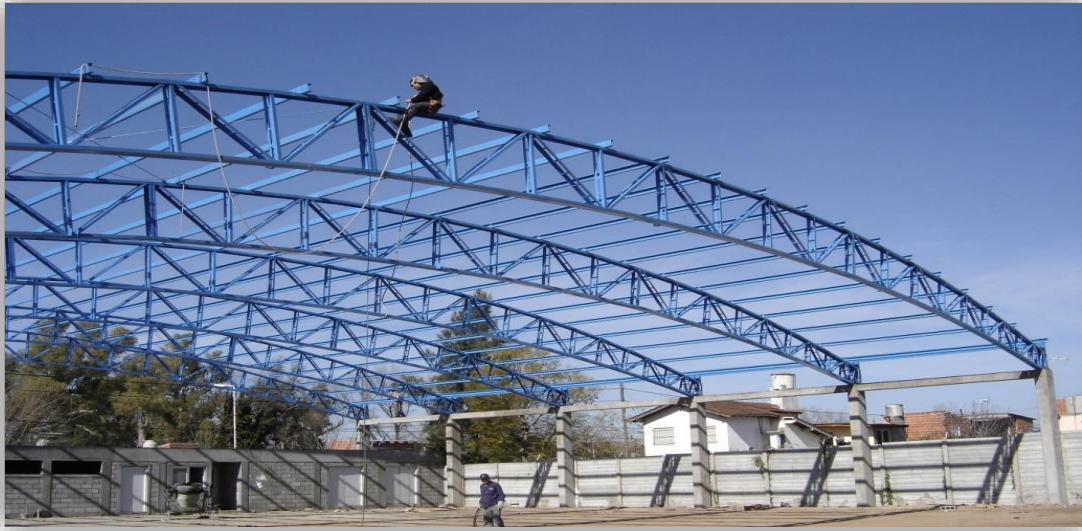
Figura 1.16. Techo parabólico en proceso constructivo. (Construtec, 2010)
