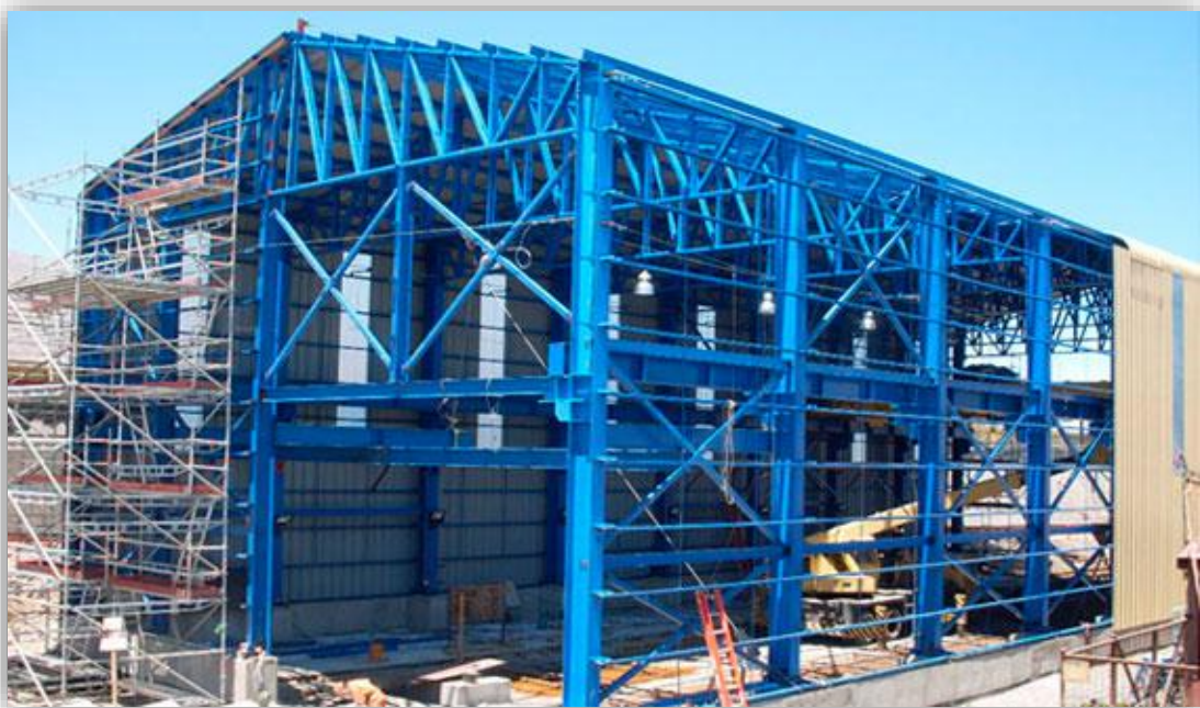
Figura 1.1. Nave industrial metálica con perfiles en celosía (ESBing, 2017)
