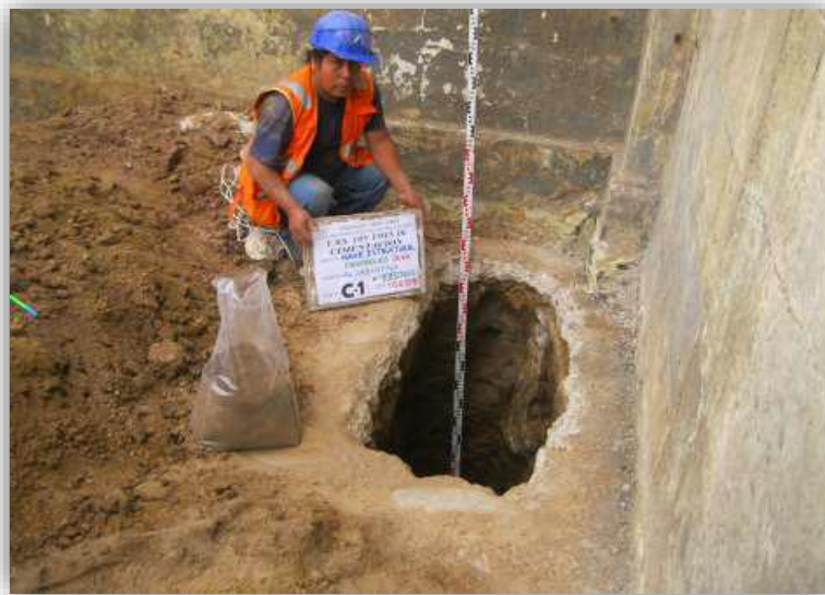
Figura 2.2. Excavación de Calicata 1 (EMS Av. Argentina)
