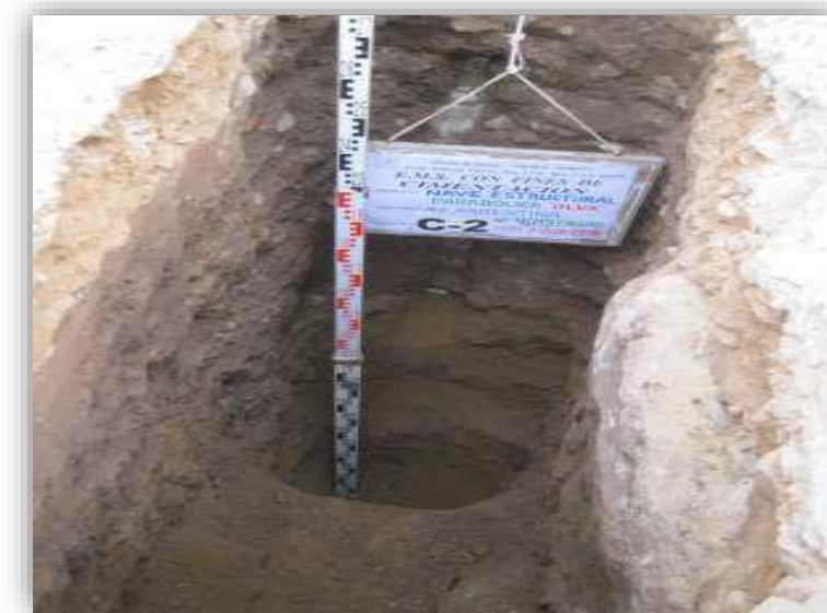
Figura 2.3. Excavación de Calicata 2 (EMS Av. Argentina)
