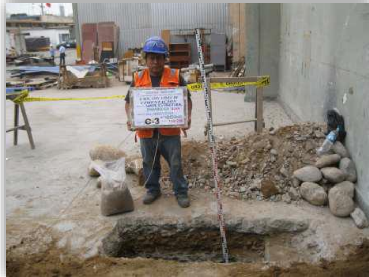
Figura 2.4. Excavación de Calicata 3 (EMS Av. Argentina)
