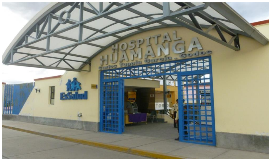
FOTOGRAFIA 1. FRONTIS DEL HOSPITAL II HUAMANGA - ESSALUD
