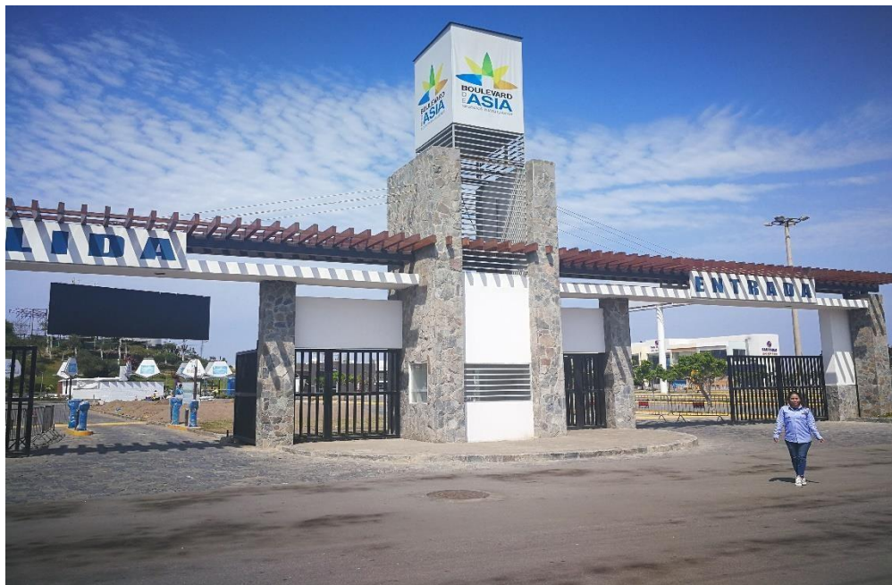
Fotografía N°17 Entrada al Boulevard de Asia
