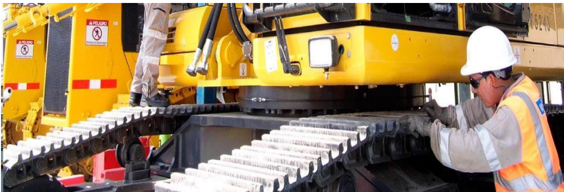
Figura25: Inspección y control de los equipos
