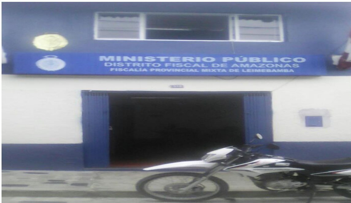
Foto 1: Fiscalía Provincial Mixta de Leymebamba, ubicado en el Jr. Bolívar N° 514
