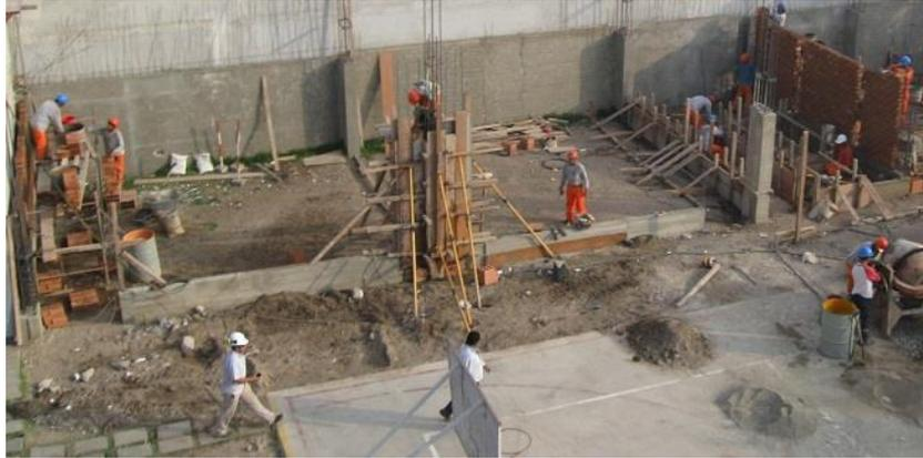
Figura III.1: Vaciado de concreto en columnas, fuente: propia.
