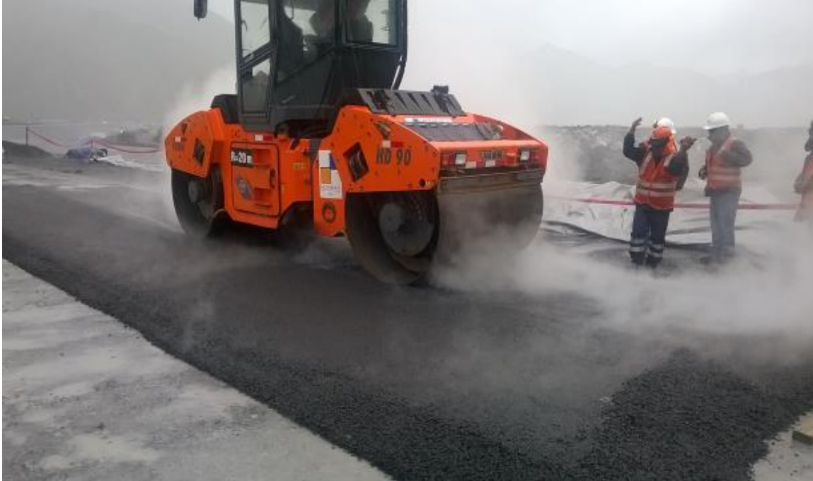
Fotografía 14: Panel test prueba interna, conformado con esparcidora de capa de concreto asfáltico de 20 cm. de espesor y compactado con rodillo tándem de 10 ton.
