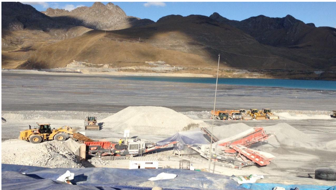
Figura N° 3 Vista panorámica de la chancadora donde se procesan los agregados para el núcleo de concreto.
