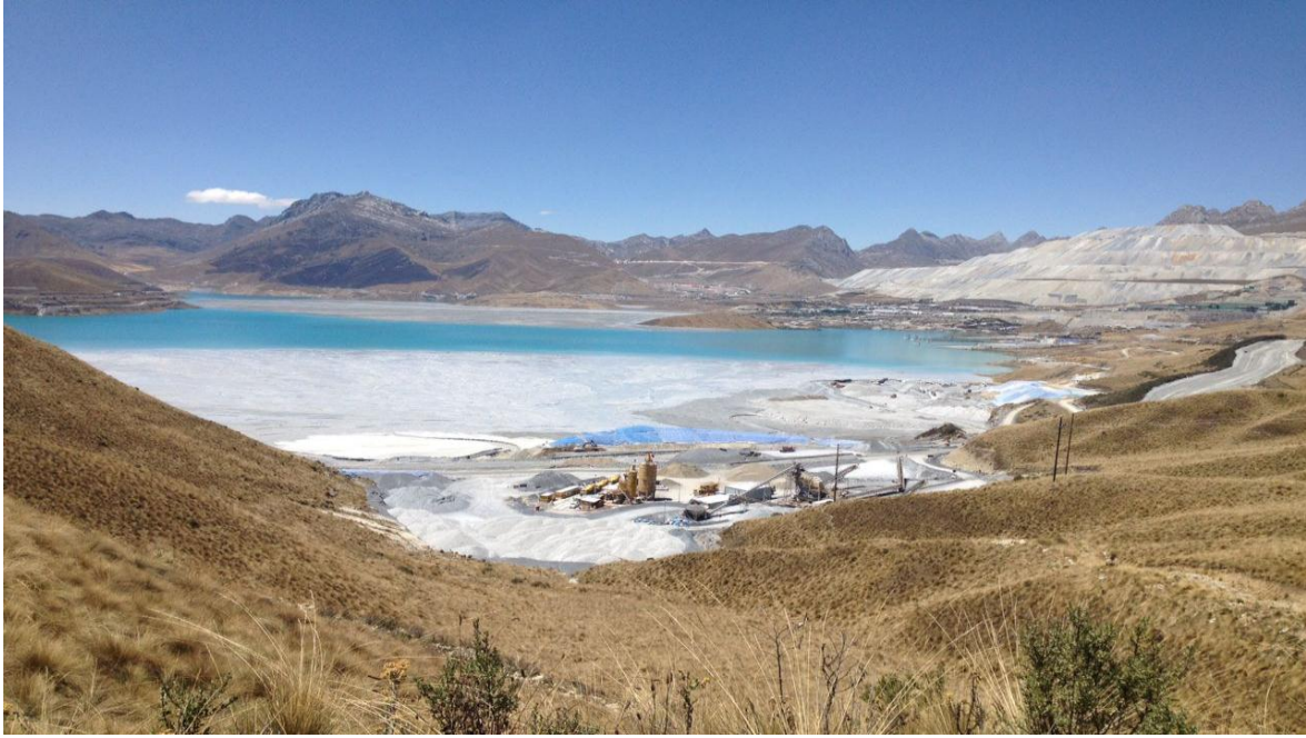
Figura 033: Vista panorámica del vaso (deposito) de la presa de relaves.
