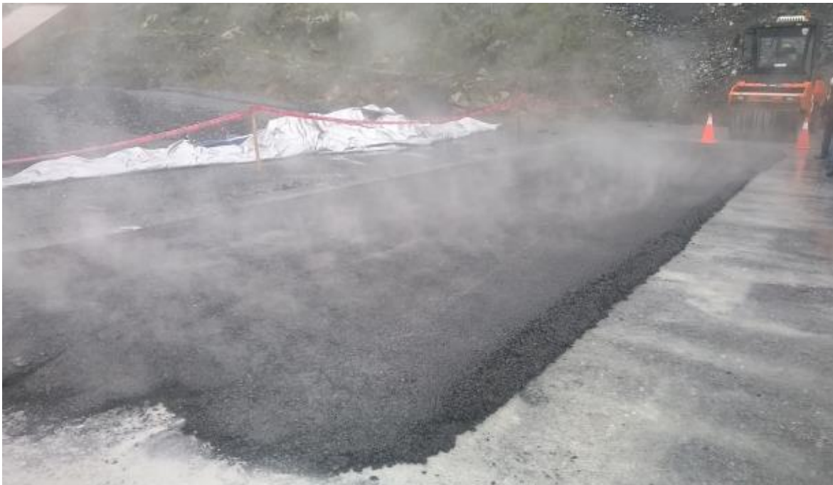
Fotografía 15: Cancha de prueba interna, colocación de capa de concreto asfáltico.
