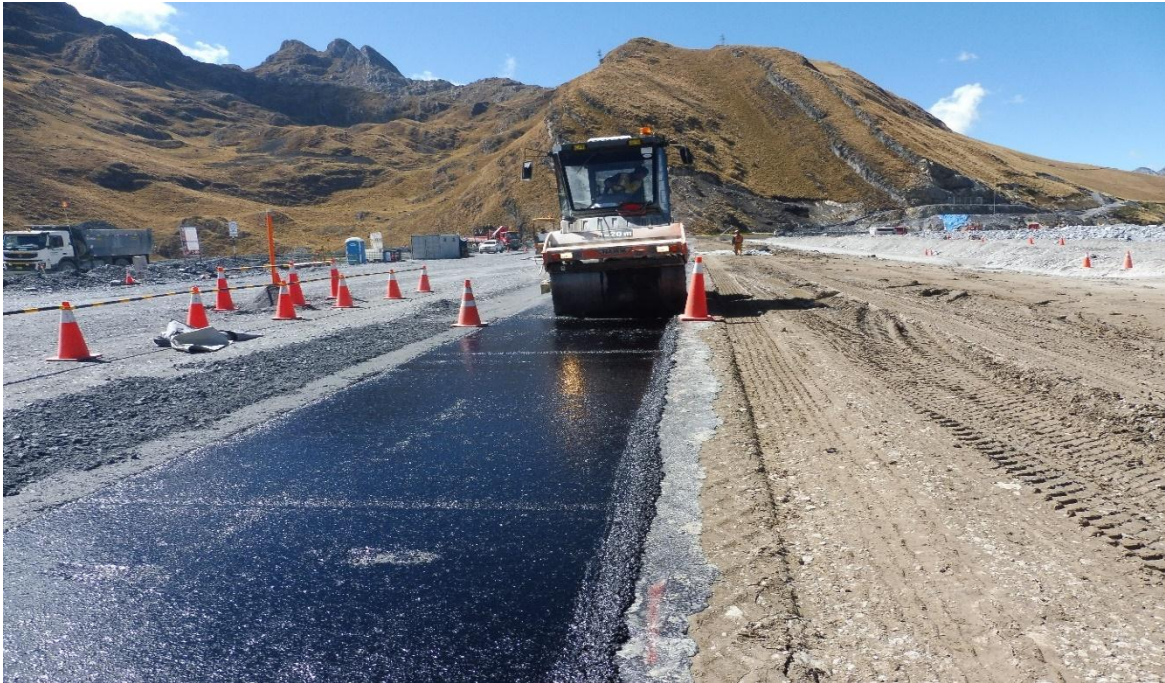
Figura 26: Compactación con rodillo tándem de 9 Tn.
