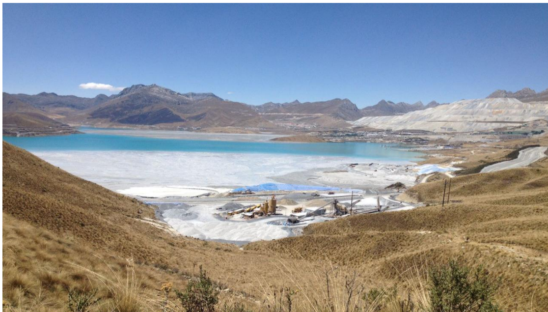
Figura N° 7 Vista panorámica del vaso (depósito) de la presa de relaves, fuente propia
