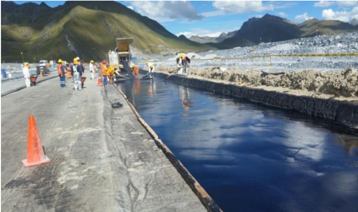
Fotografía 20: Colocación de mastic sobre la geomembrana bituminosa entre las progresivas 0+320 km hasta la 0+370 km.
