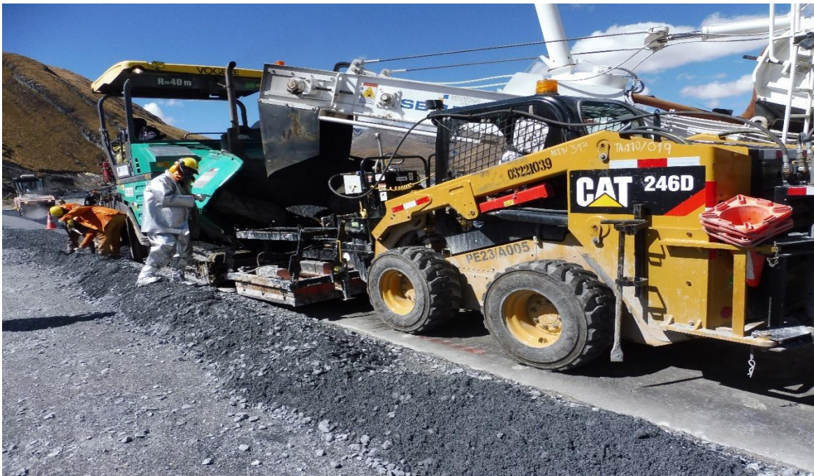
Fotografía 23: Calentador siempre pegado a la esparcidora, para evitar enfriamiento en tramos más largos.
