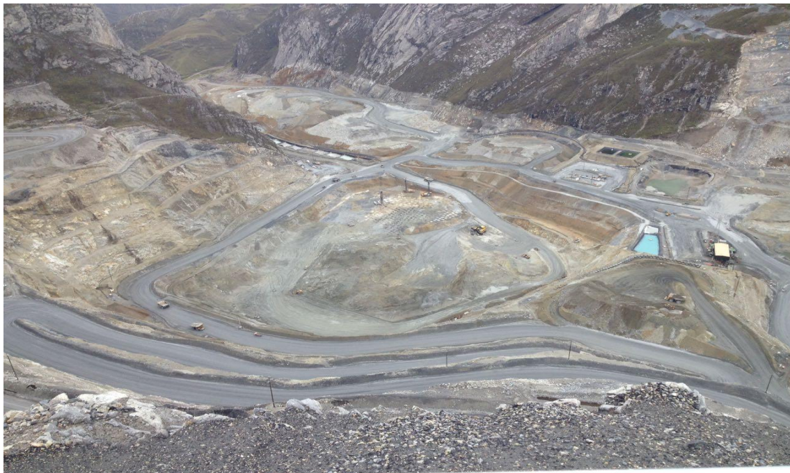
Figura N° 10 Vista panorámica del tajo de mina
