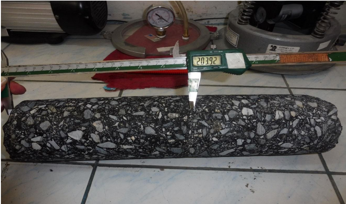
Figura 30: Núcleo extraído de la capa colocada con concreto asfáltico.
