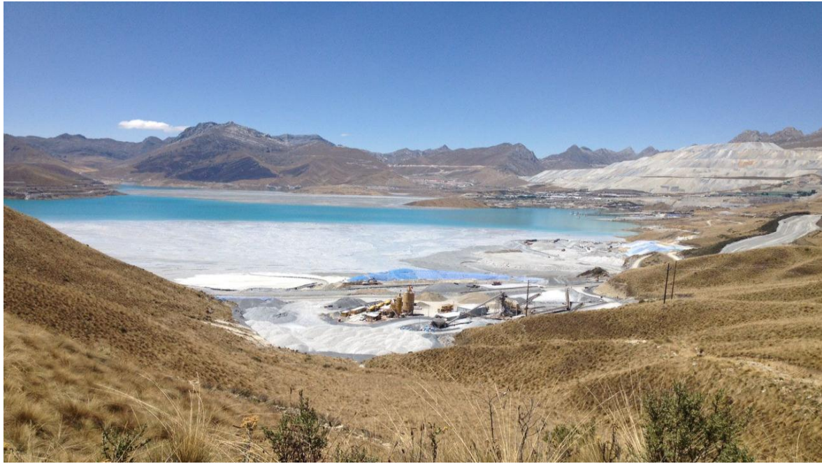
Figura N° 2 Vista panorámica del vaso (deposito) de la presa de relaves.
