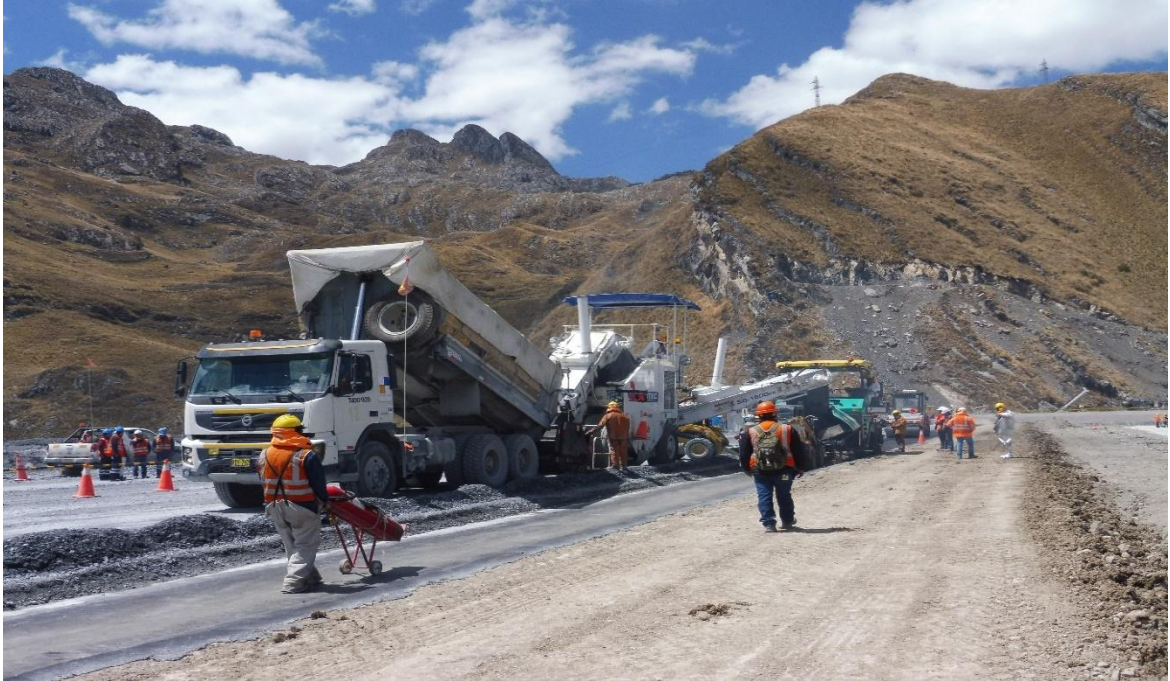
Figura 24: Vista del tren de asfalto en el proceso de colocación del concreto asfáltico.
