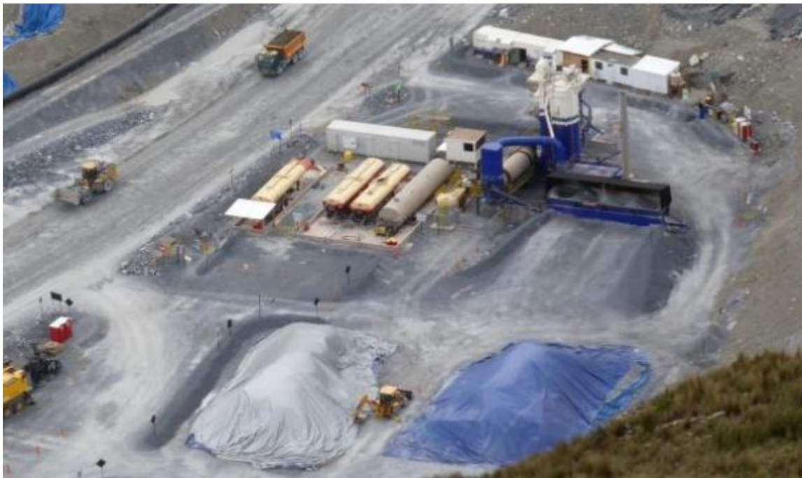
Fotografía12: Vista panorámica de la planta de asfalto instalada.
