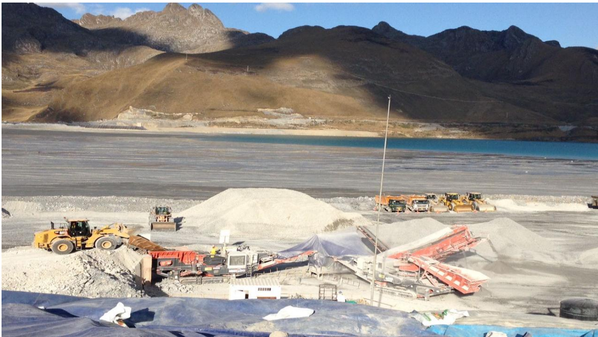
Figura 044: Vista panorámica de la chancadora donde se procesan los agregados para el núcleo de concreto asfáltico
