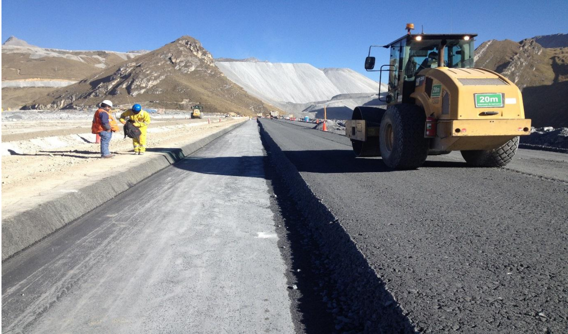
Figura 32: Trabajos de compactación al material 2B calcáreo colocado aguas abajo para confinar el núcleo de concreto asfáltico.
