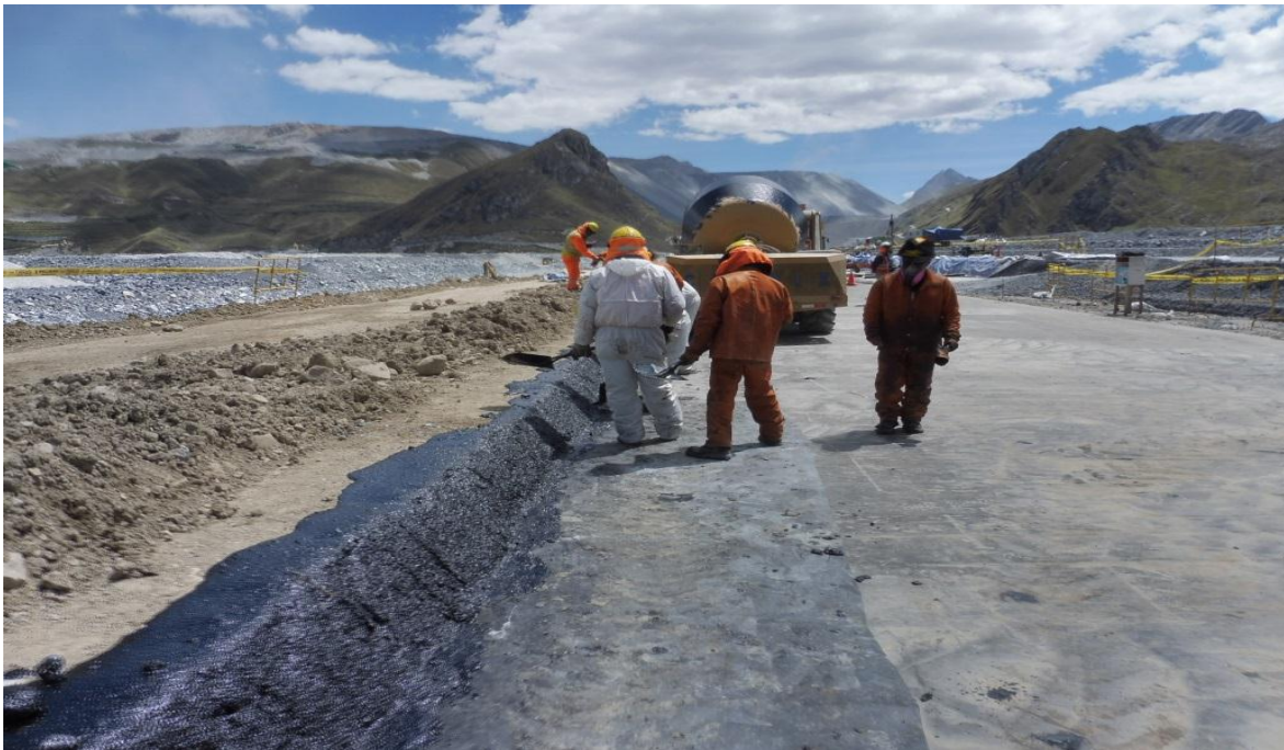
Fotografía 19: Acabado de la colocación de mastic asfáltico sobre talud de la morrena.
