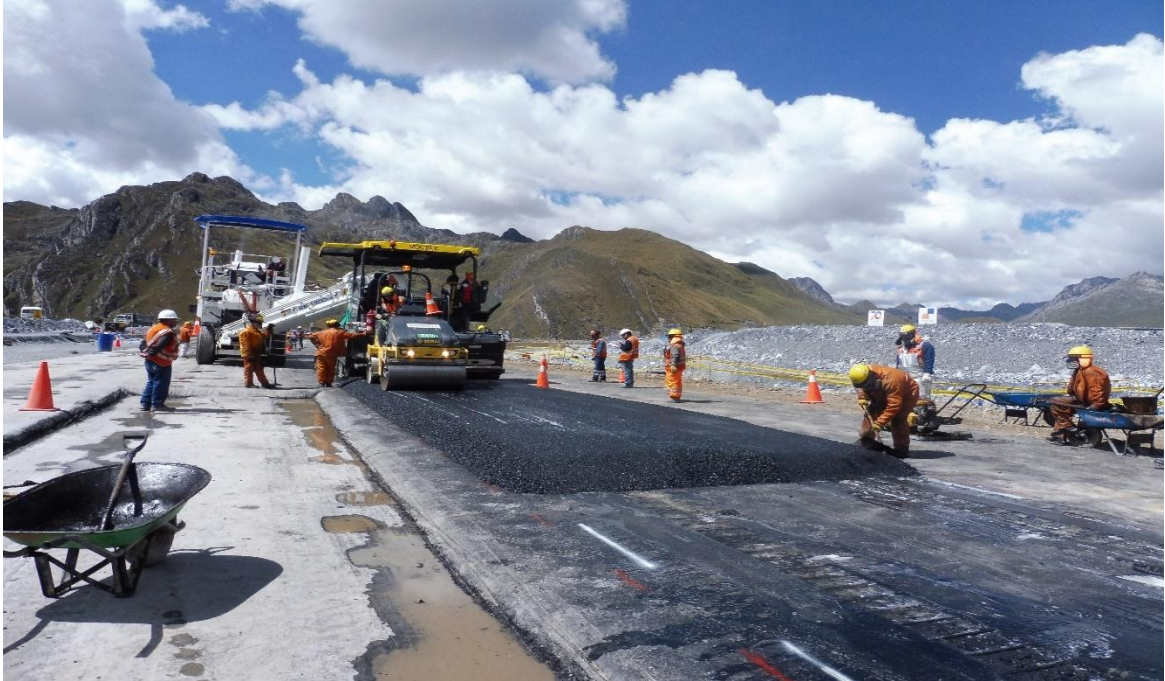
Fotografía 22: Colocación de concreto asfáltico sobre la geomembrana bituminosa para conformar la base (zapata) del núcleo asfáltico.
