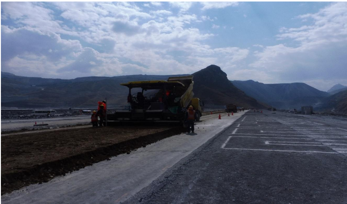
Figura 31: Colocación de material de baja permeabilidad para confinar el núcleo de concreto asfáltico.
