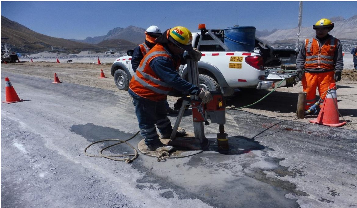
Figura 29: Trabajos de extracción de núcleos con equipo de diamantina.
