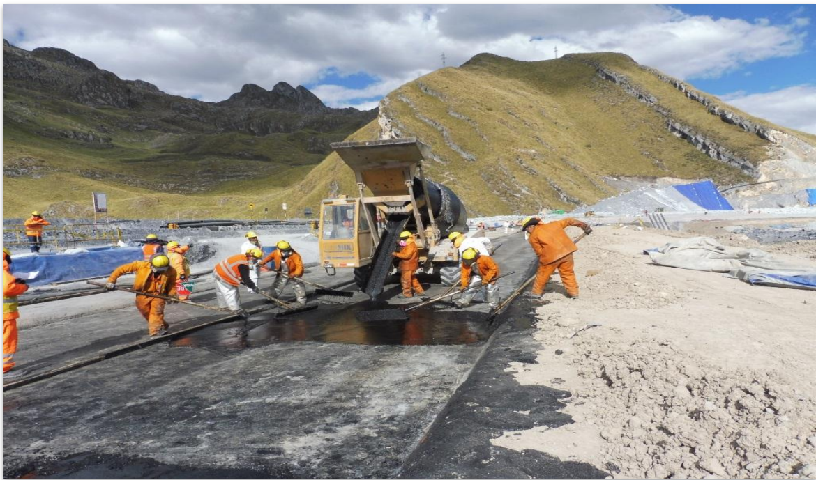
Fotografía 21: Colocación de mastic sobre la geomembrana bituminosa.
