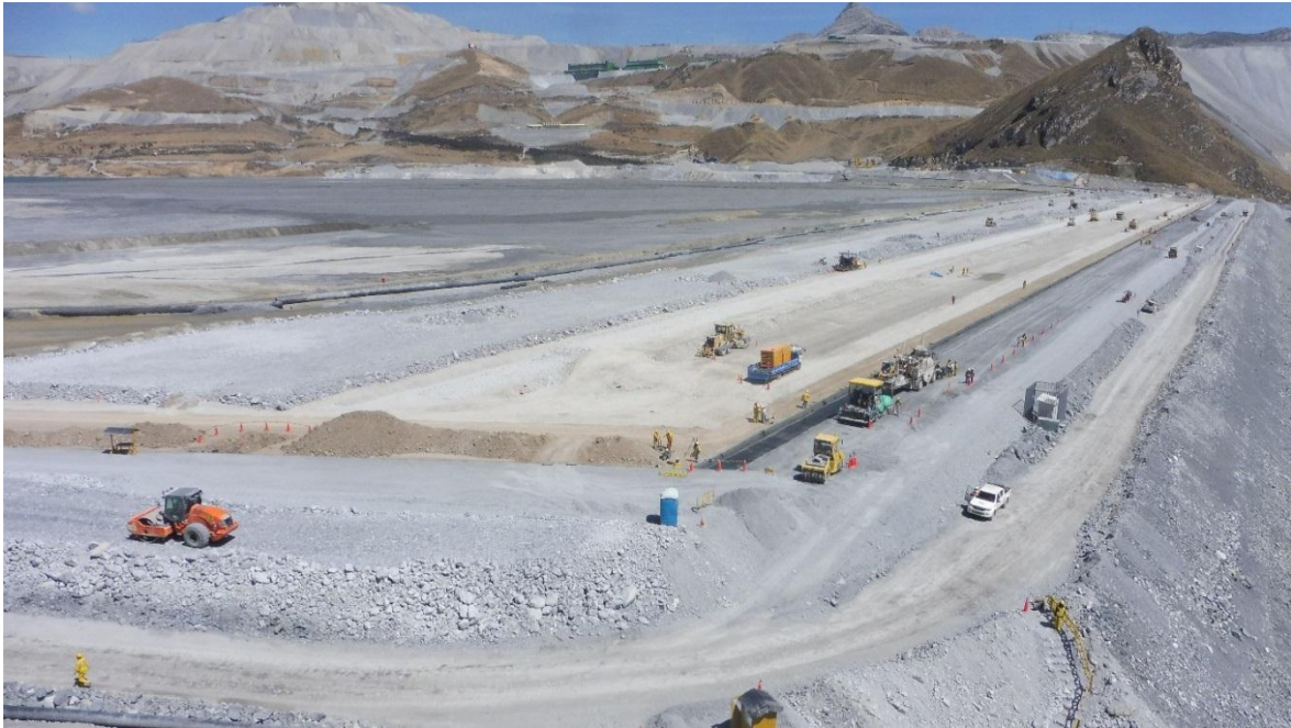
Figura 055: Vista panorámica de la presa de relaves tomada desde el estribo derecho
