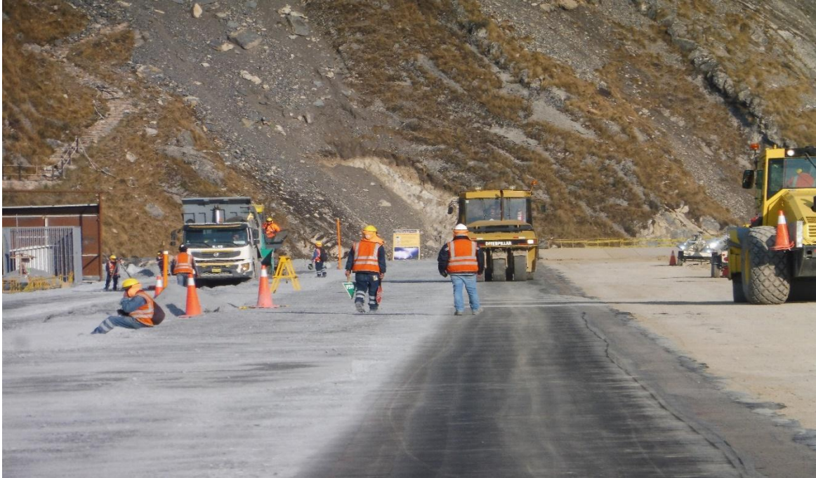
Figura 28: Trabajos de compactación con rodillo de neumático.
