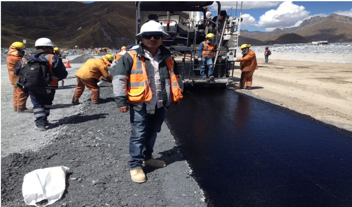
Figura 27: Vista panorámica de capa colocada con concreto asfáltico.
