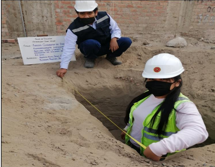
Figura 12. Medición de calicata
