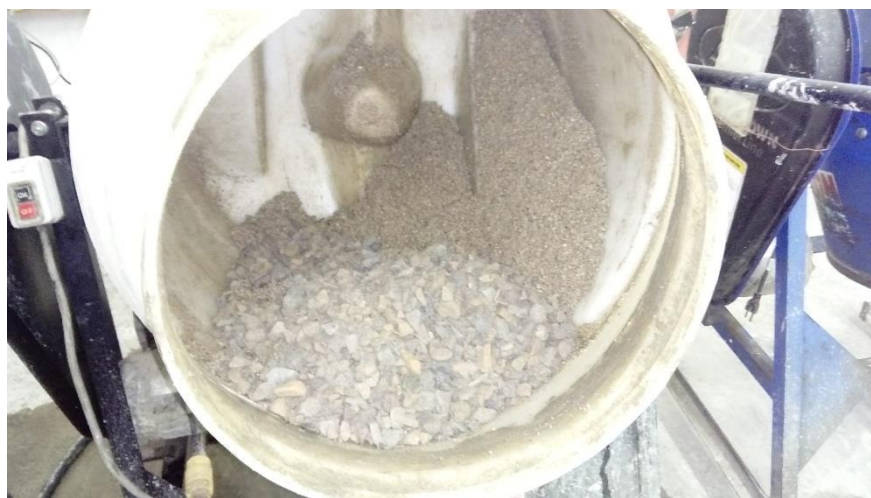
Figura III. 11 Elaboración de la Mezcla de concreto, donde ingresan los agregados, el cemento, agua y aditivo.
