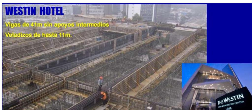
Figura 1-5: Mayor Longitud de la estructura sobre apoyos,
