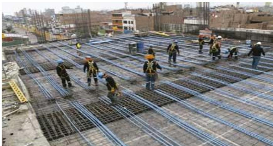
Figura 1-1: Sistema postensado en el CC Mega plaza obra realizada por VSL Perú, Revista Constructivo Agosto 2016.
