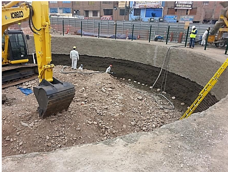
IMAGEN 4. 1 colocación de malla electro soldada y lanzamiento de shotcrete
