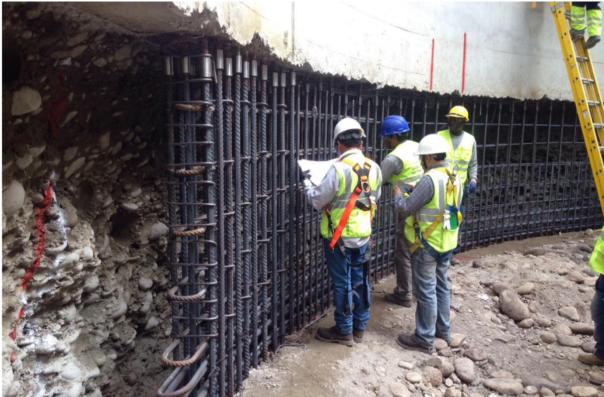
IMAGEN 4. 5 Instalación de acero de anillo inferior con conectores mecánicos
