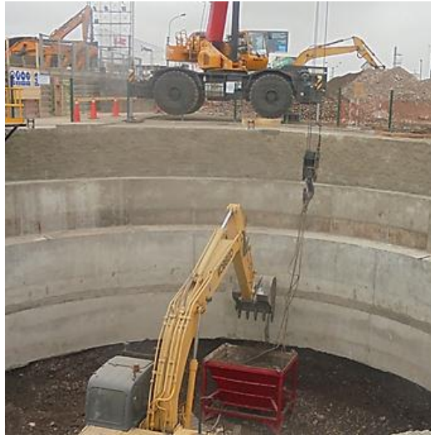
IMAGEN 4. 3 Excavación de anillos en pozo
