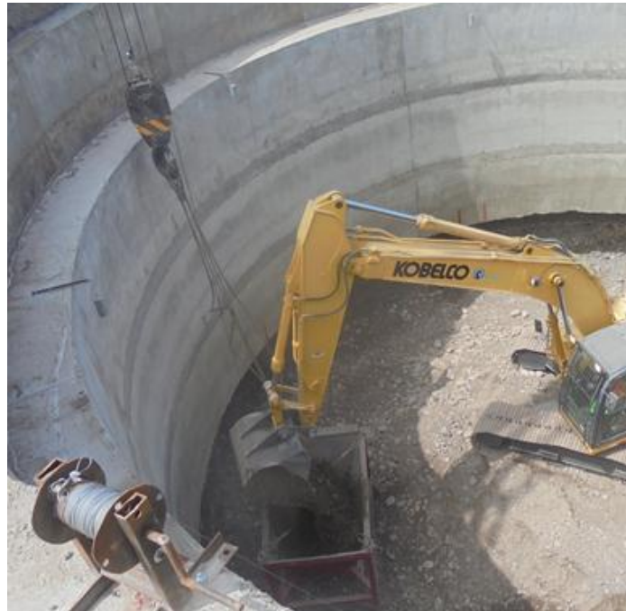
IMAGEN 4. 4 Excavación de anillos en pozo
