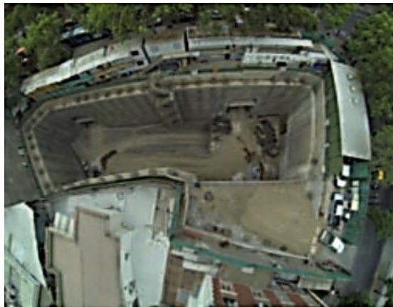
IMAGEN 1. 2 excavación en los leones en líneas 1 y 2
