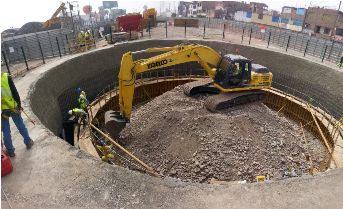
IMAGEN 4. 6 Colocación de encofrado
