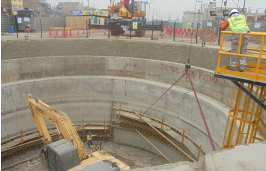
IMAGEN 4. 8 Sistema de izaje de encofrados en pozos- grúa torre o autopropulsada
