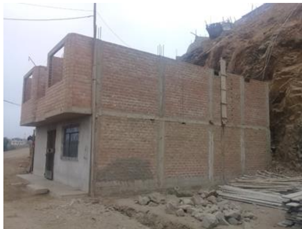
Fotografía N°. Ubicación de la vivienda. Fuente: Elaboración propia.
