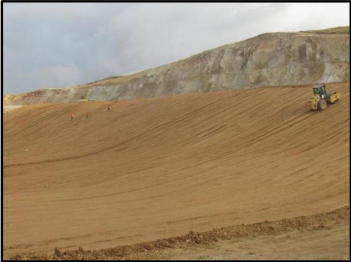
*Figura N° 22: Compactación del suelo de baja permeabilidad*
