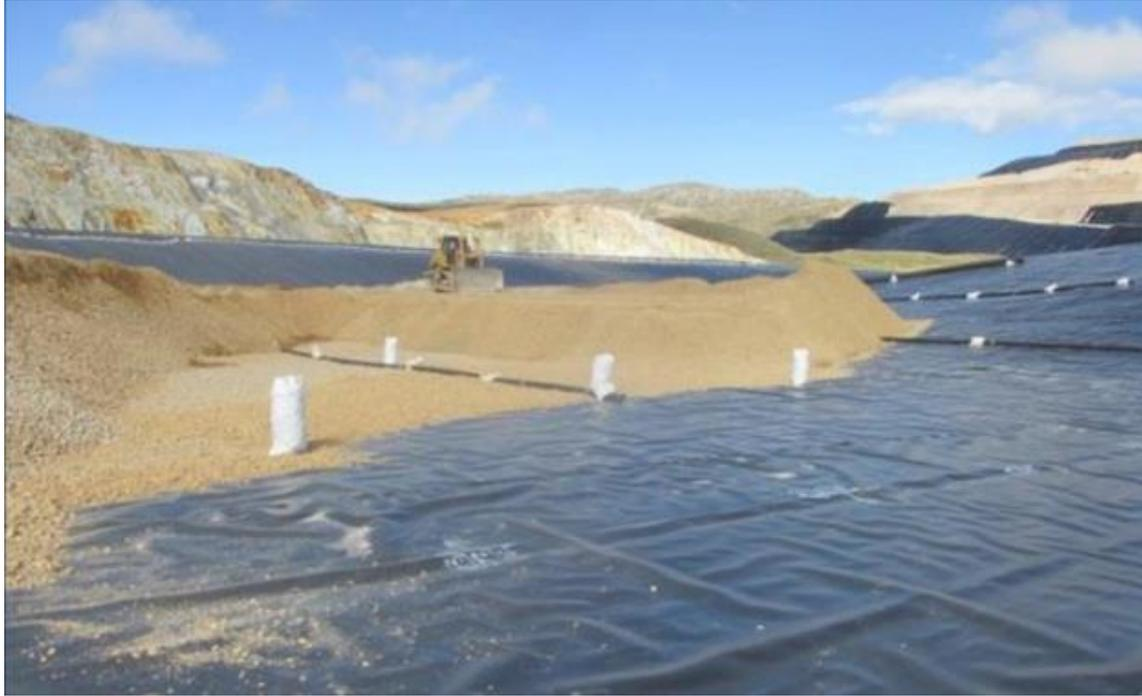
*Figura N° 28: Colocación del material de Sobrevestimiento*
