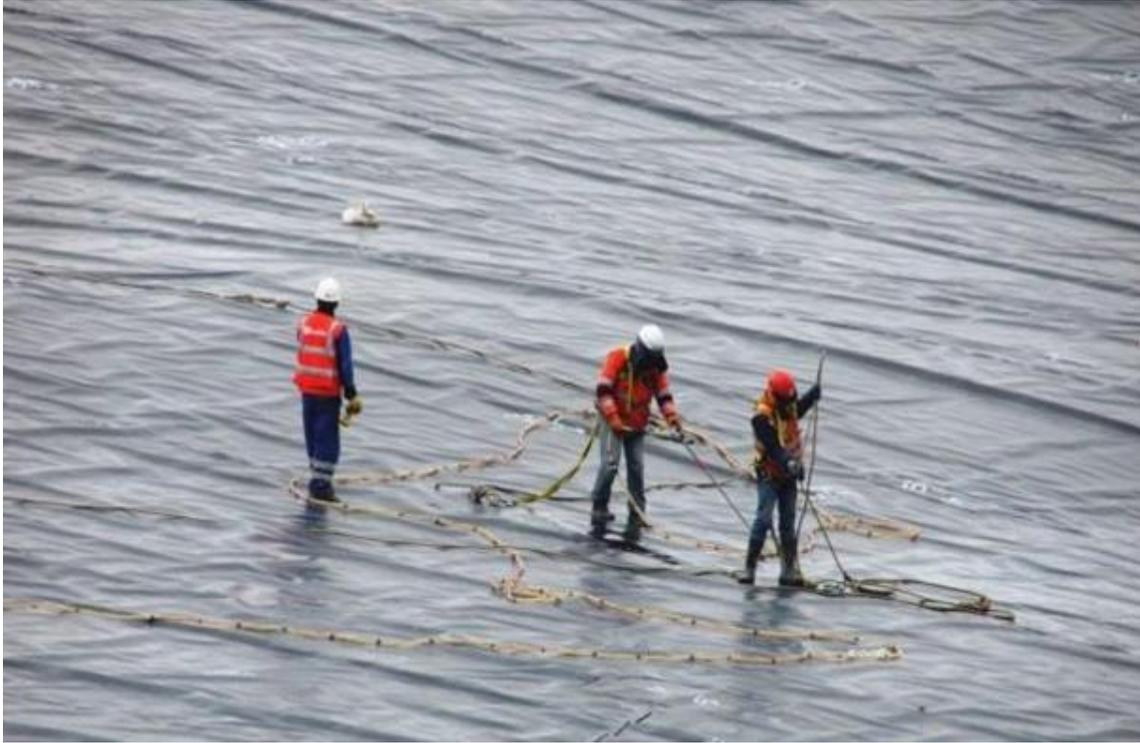
*Figura N° 27: Prueba Geoeléctrica (Lanza de Agua)*
