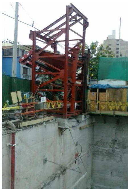
Figura 9 Torre de control de Método de Izaje Vertical
