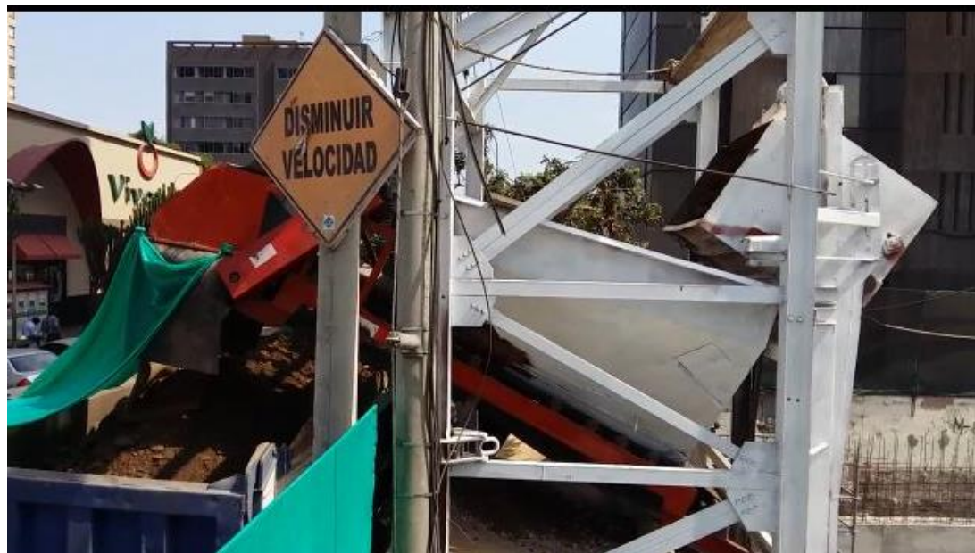
Figura 16 Tolva de camión esperando descarga - Método de Izaje
