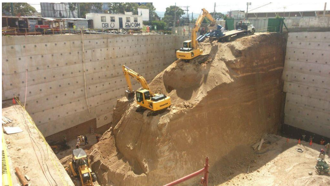
Figura 1 Banquetas usando retroexcavadoras para la eliminación, confina el área de trabajo
