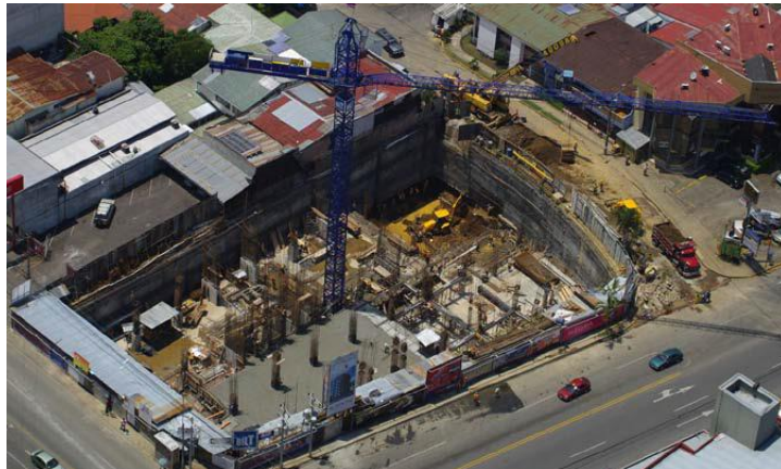
Figura 12 Grúa Torre en proceso de ejecución de obra
