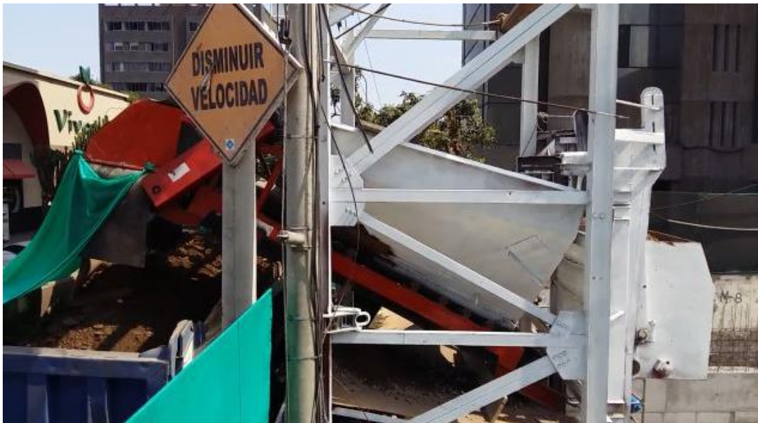
Figura 17 Método de Izaje Vertical, momento de bajada
