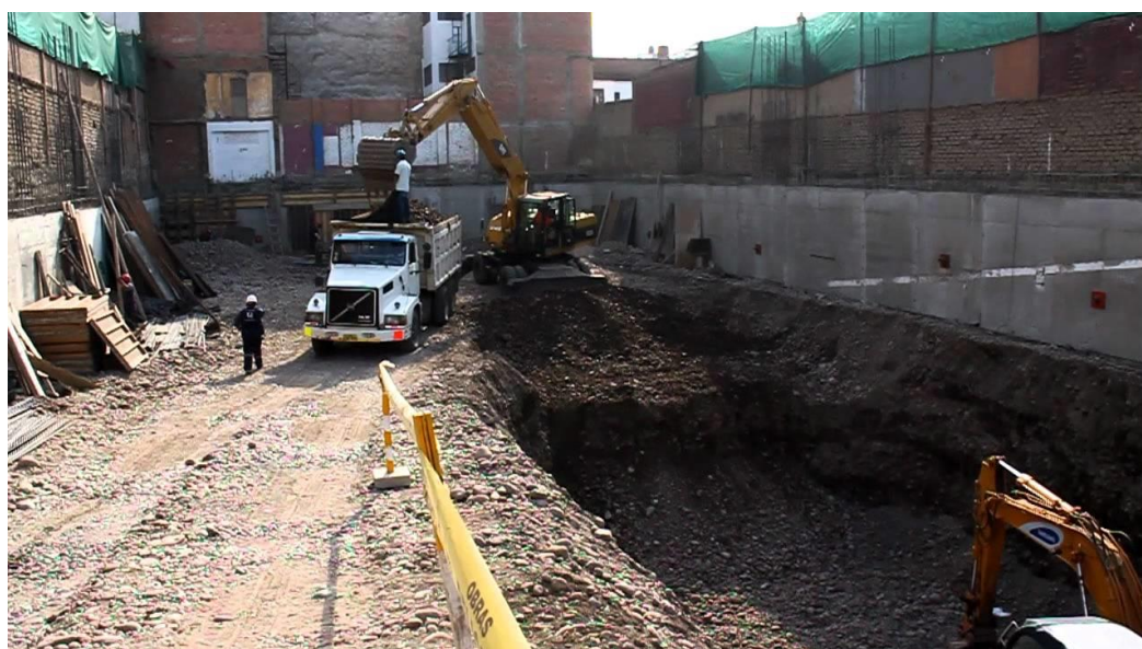
Figura 3 Proceso de eliminación de material extraído que paraliza la realización de otras actividades
