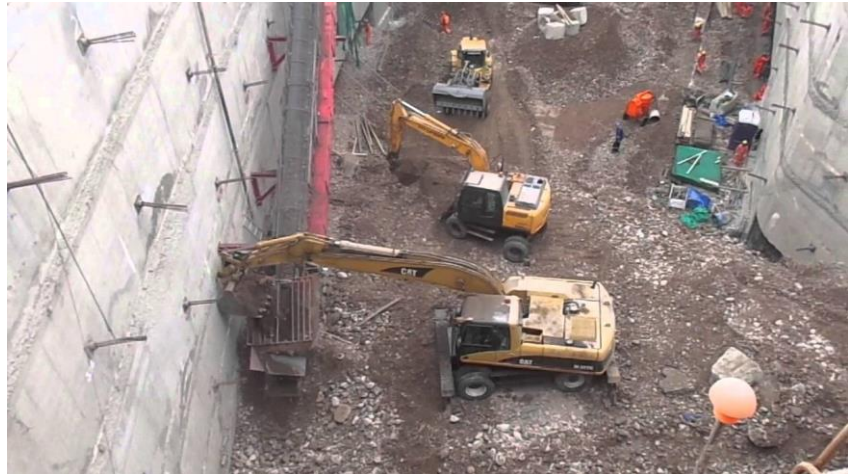
Figura 6 Excavadoras alimentando faja
