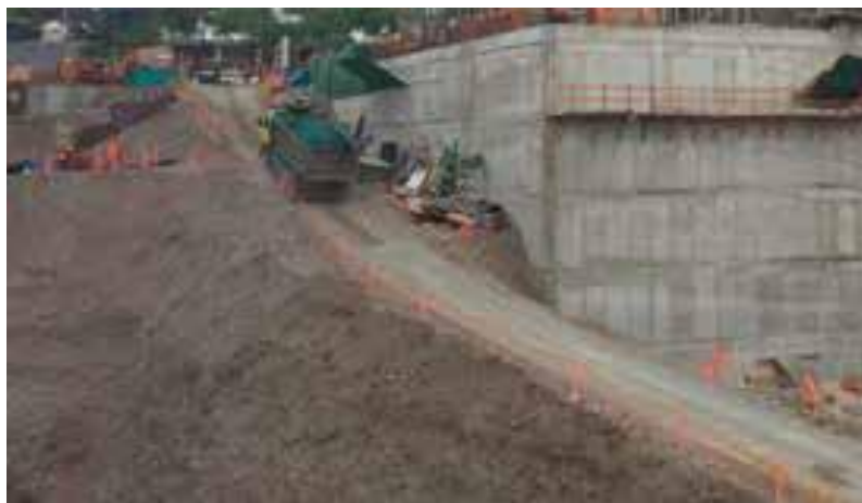
Figura 4 Eliminación Usando Rampa
