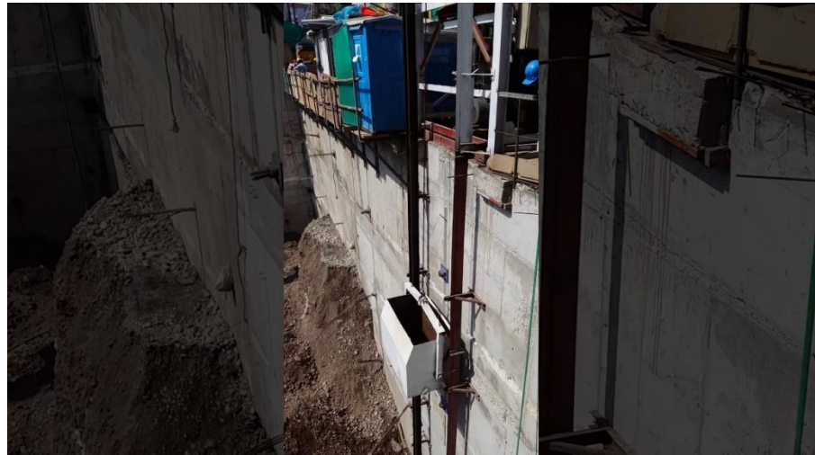
Figura 10 Eliminación mediante Método de Izaje Vertical
