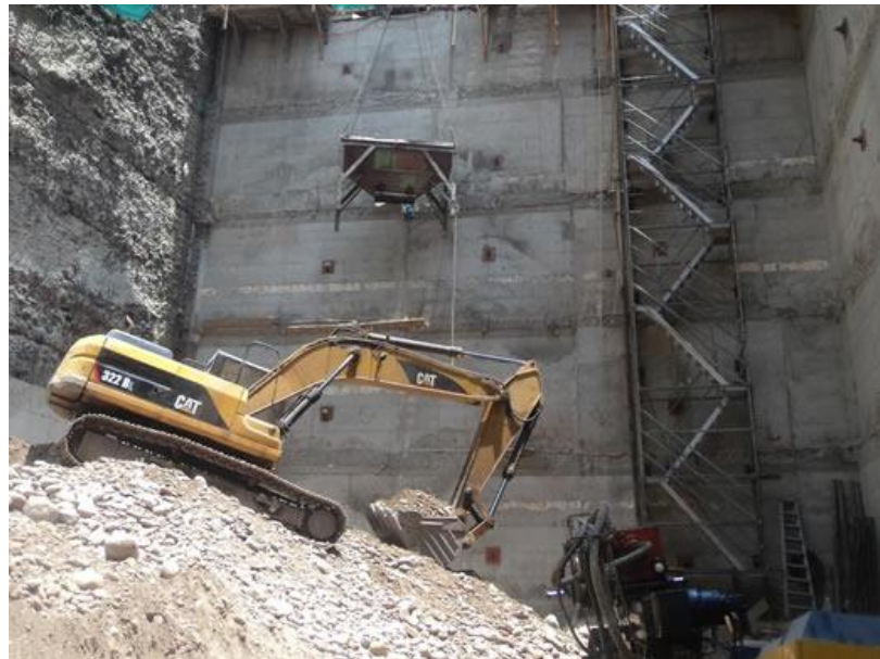
Figura 11 Método de Grúa Torre con Baldes Basculantes
