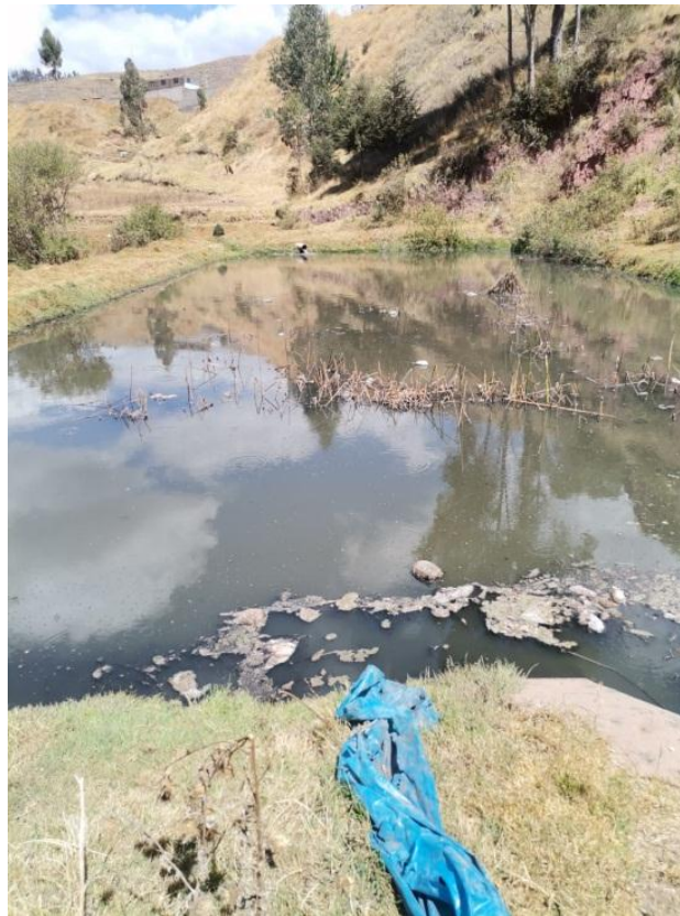
Figura 08 Estructura de la PTAR
