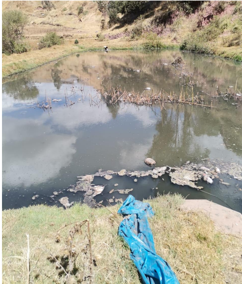
Figura 22 Laguna de estabilización
