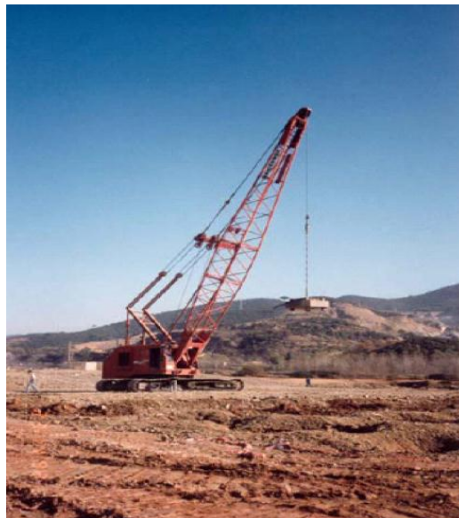
Figura 1-8 Compactación dinámica clásica (CDC)
