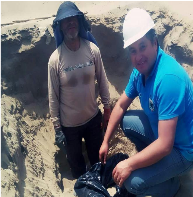
Extracción de Calicata 4
