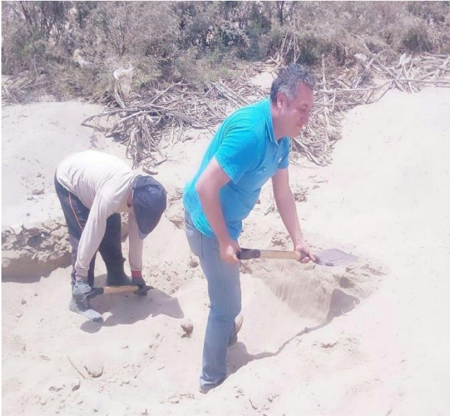
Extracción de Calicata 3
