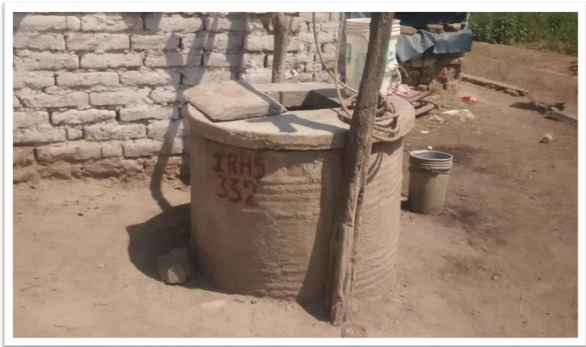
Vista: Sistema actual Sanitario, Centro Poblacional Quinta la Gloria
