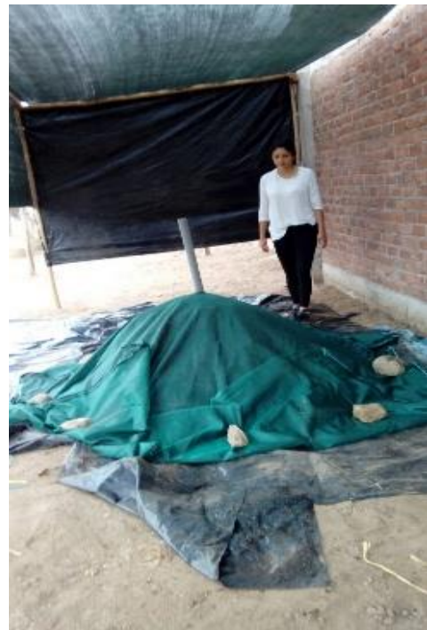
Fotografía N° 33. Reposo de la mezcla Fuente: Propia
