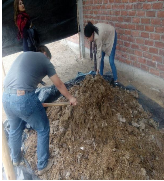
Fotografía N° 30. Comprobando la humedad de la mezcla Fuente: Propia
