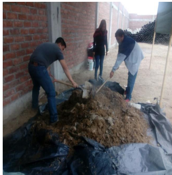
Fotografía N° 29. Mantenimiento de la mezcla Fuente: Propia
