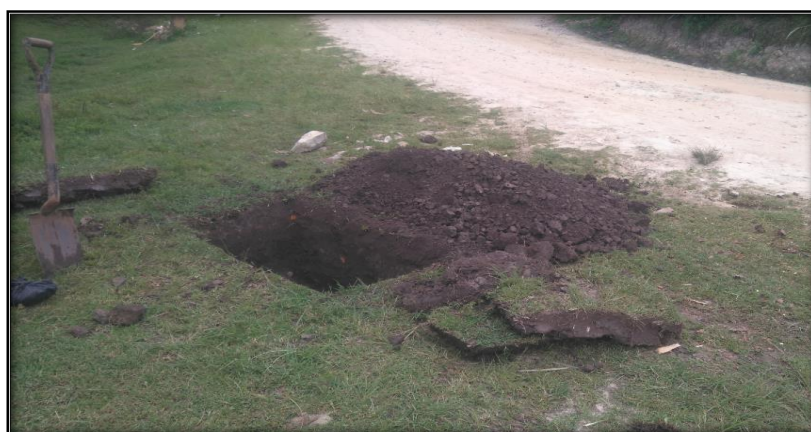
Figura 22: Calicata realizada en la zona baja de la carretera Fuente: Tesista
