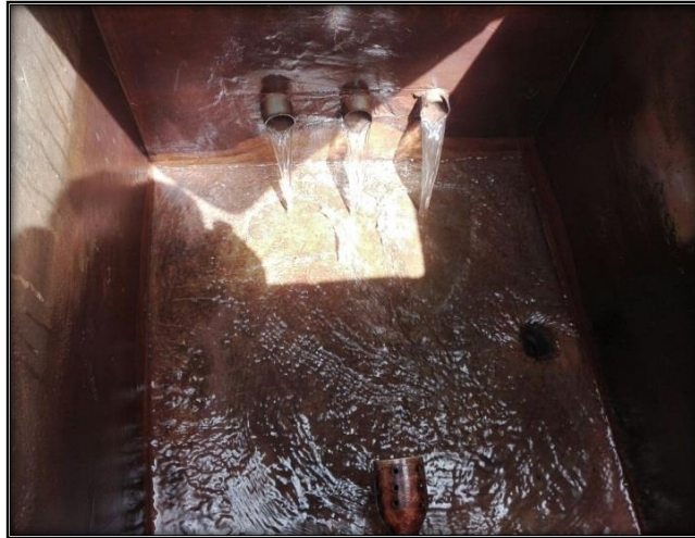
Figura 17: Captación existente Fuente: Tesista
