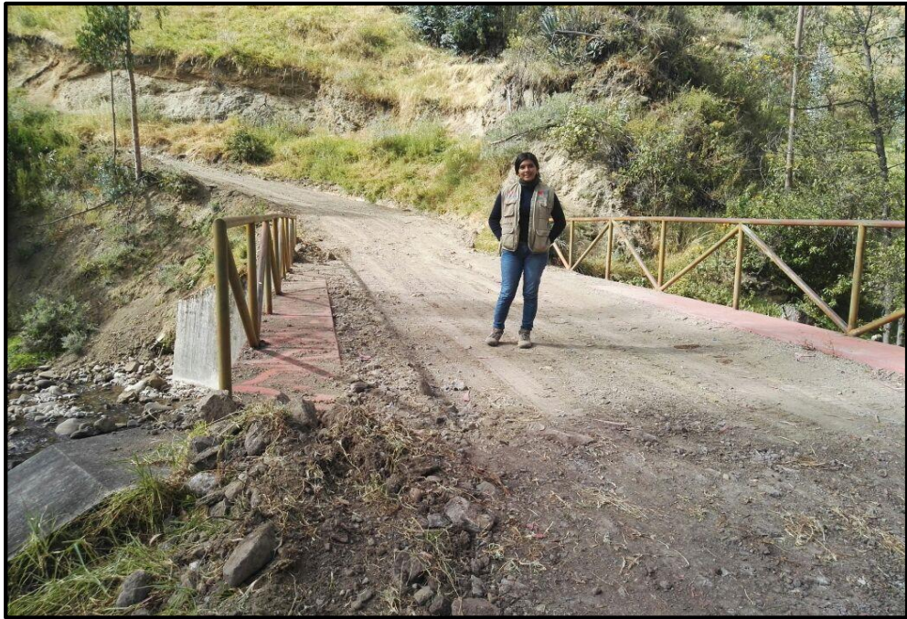
Anexo N° 16 Pontón de concreto armado en buen estado.
