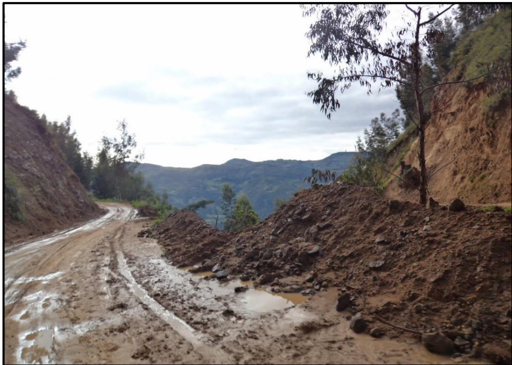
Anexo N° 2 Estado actual de la vía.
