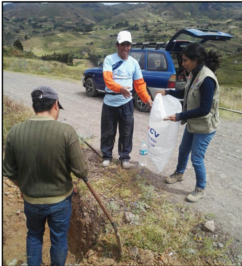
Anexo N° 17 Extracción de muestras de suelos de las calicatas.
