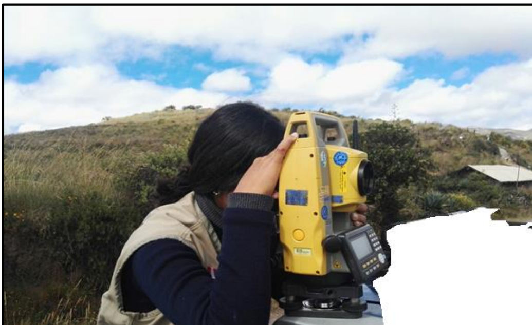
Anexo N° 13 Realización del levantamiento topográfico.
