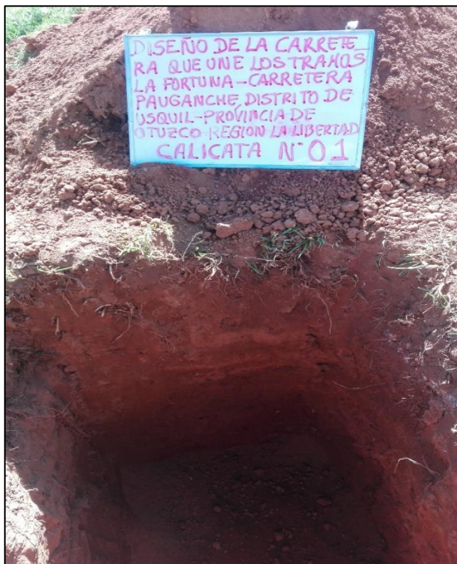
Anexo 02 – Figura 46: calicata 1 (C-1)
