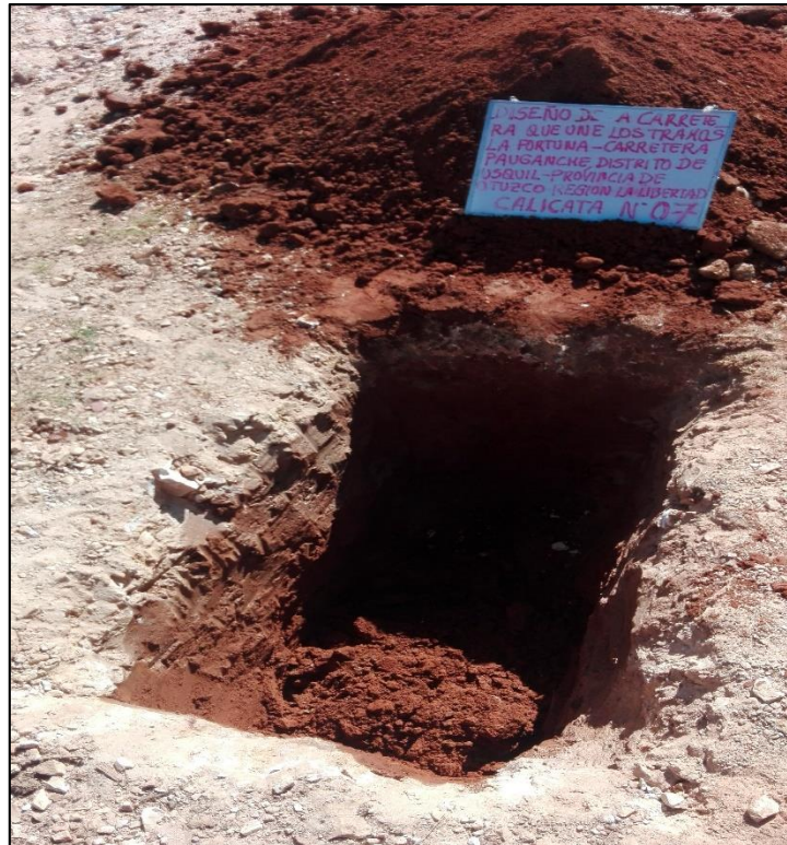
Anexo 02 – Figura 52: calicata 7 (C-7)
