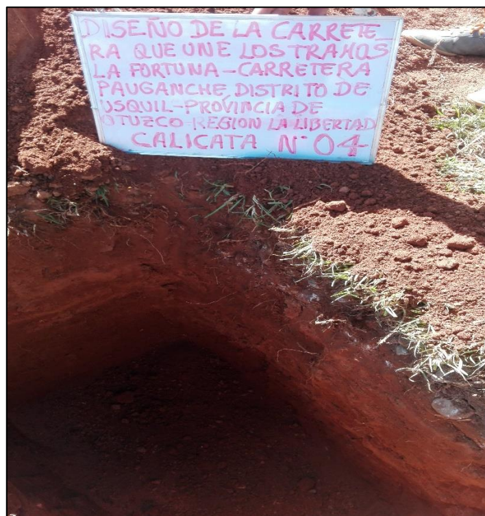
Anexo 02 – Figura 49: calicata 4 (C-4)
