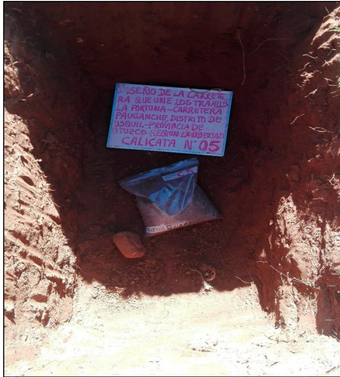
Anexo 02 – Figura 50: calicata 5 (C-5)
