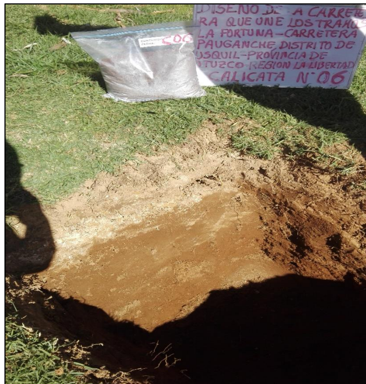
Anexo 02 – Figura 51: calicata 6 (C-6)
