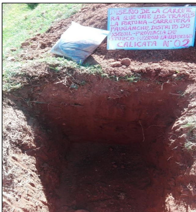
Anexo 02 – Figura 47: calicata 2 (C-2)
