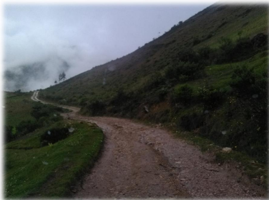
DESCRIPCIÓN Laderas inclinadas con vegetación y tierra suelta
