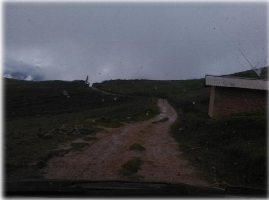
DESCRIPCIÓN Carretera angosta y con vegetación en el eje de la vía
