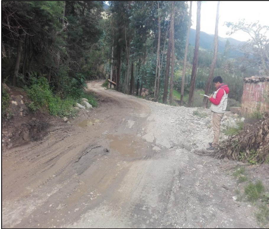
Ancho de calzada de 3.60m
