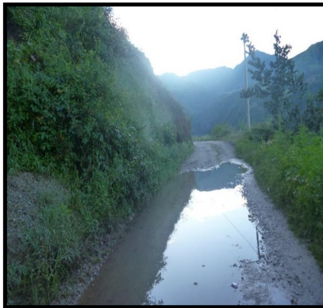
Imagen 4: Escurrimiento del agua por la vía
