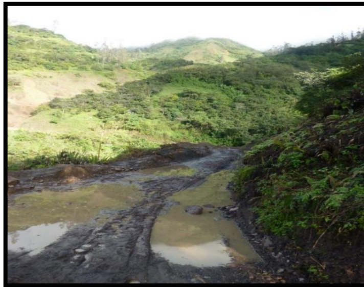
Imagen 6: Derrumbes y charcos de agua en la vía
