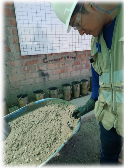
Figura III-41: Temperatura del concreto.
