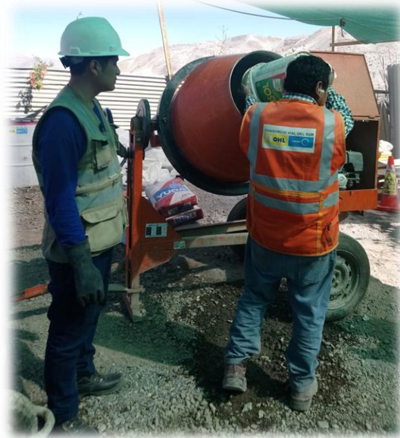
Figura III-39: Los agregados dentro al trompo mezclador.
