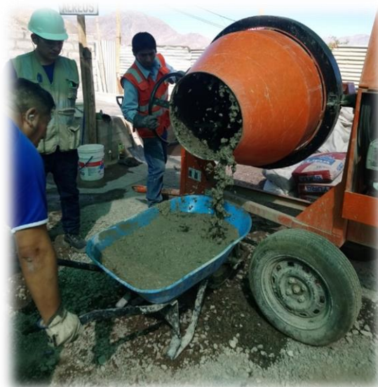
Figura III-40: Vaciado de la mezcla al bugui.
