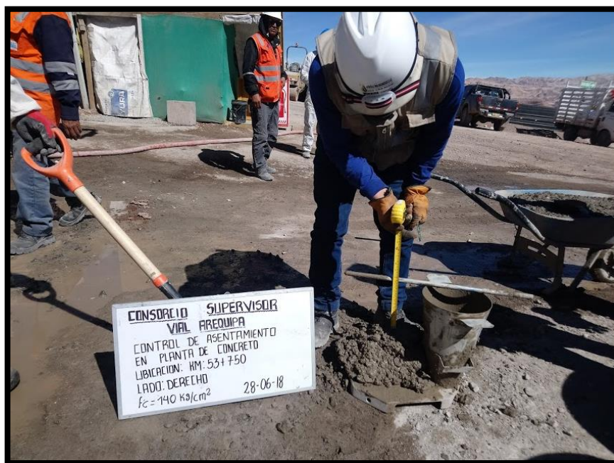
Figura I-8: Control de Slump en la planta de concreto
