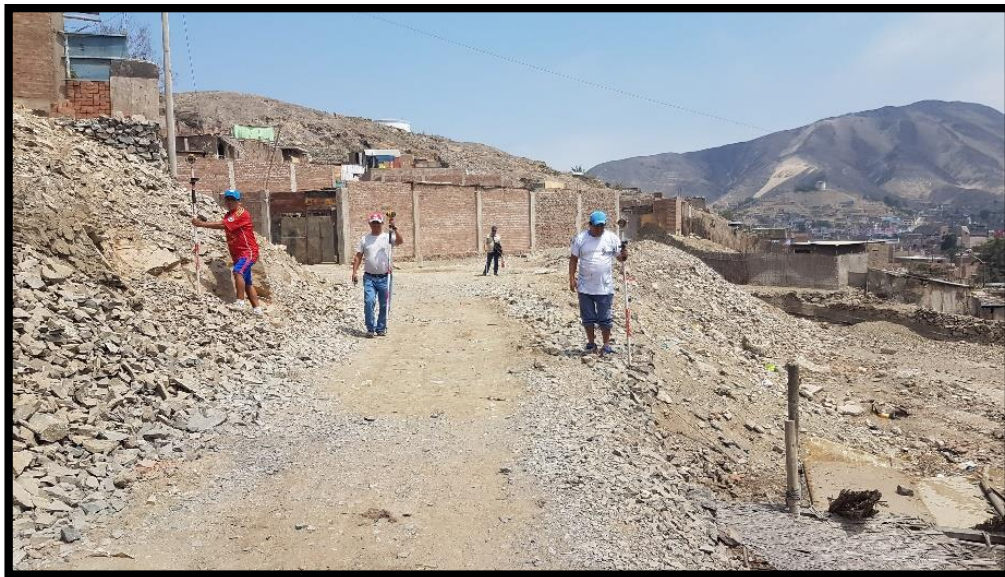
Levantamiento Topográfico: Punto Central y laterales de la carretera
