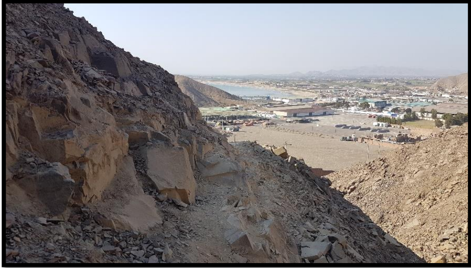
Malas condiciones de la vía
