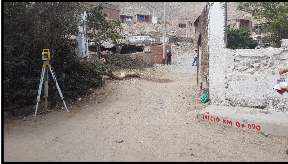
Inicio del levantamiento topográfico
