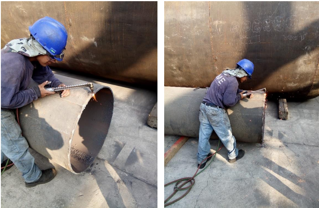
Figura N° 43: Operario cortando el tubo
