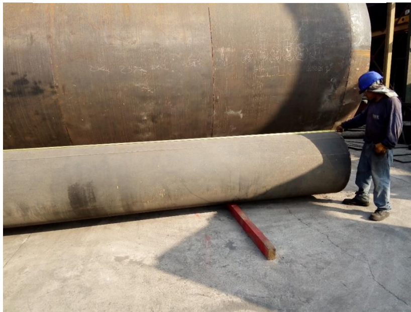
Figura N° 39: Operario trazando el tubo
