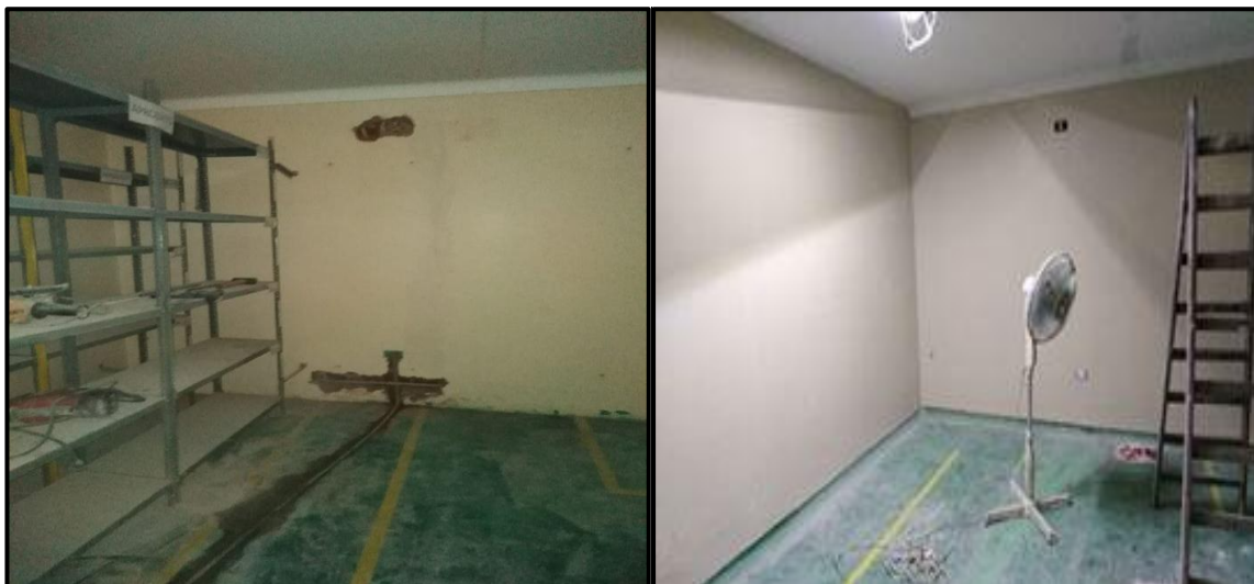
Figura N° 21: El antes y el después del empotramiento en el almacén
