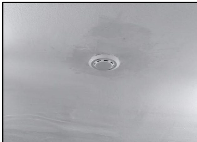
Figura N° 16: Instalación de detectores de humo
