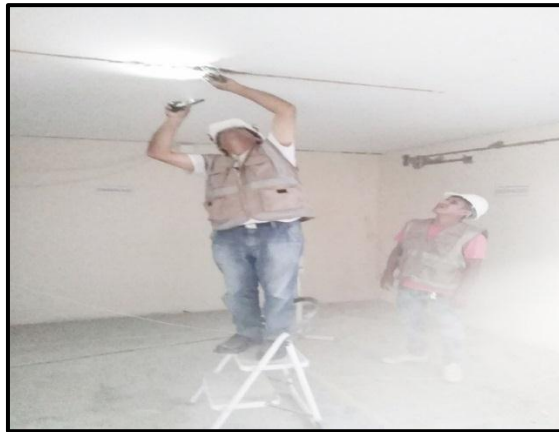
Figura N° 15: Empotramiento del sistema eléctrico para el detector de humo
