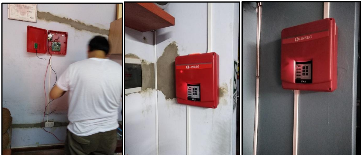
FIGURA N° 15: Instalación de sistema de detectores de humano
