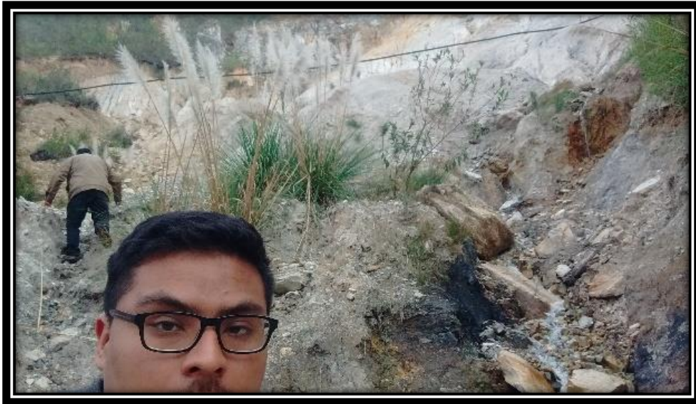
Figura 5: Pase aéreo en mal estado
