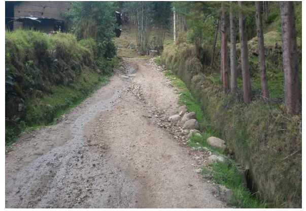
Se observa filtración en la carretera
