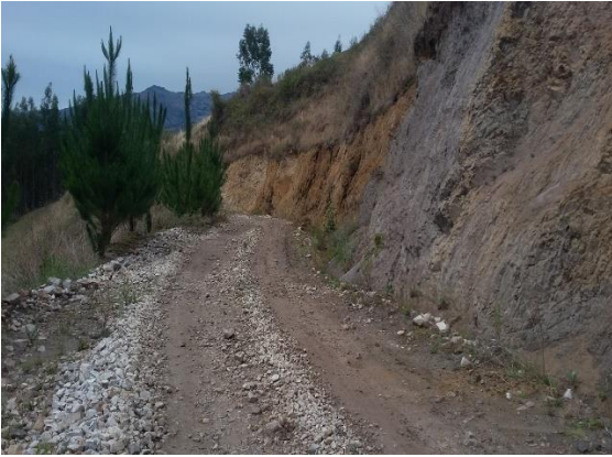
Taludes bastantes pronunciados
